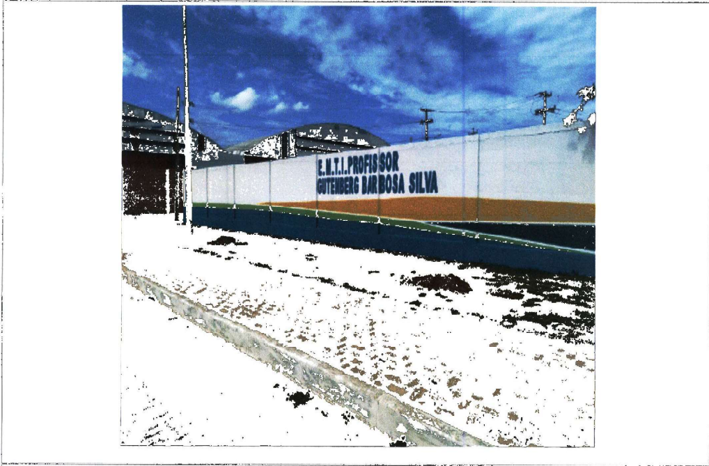
PINTURA DA FACHADA
