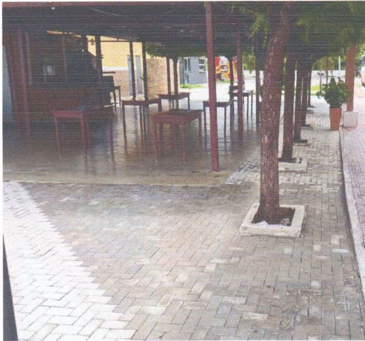
EXECUÇÃO DE PAVIMENTAÇÃO COM INTERTRAVADO
