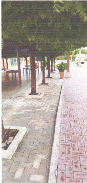
EXECUÇÃO DE PAVIMENTAÇÃO COM INTERTRAVADO
