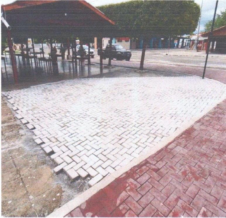
EXECUÇÃO DE PAVIMENTAÇÃO COM INTERTRAVADO
