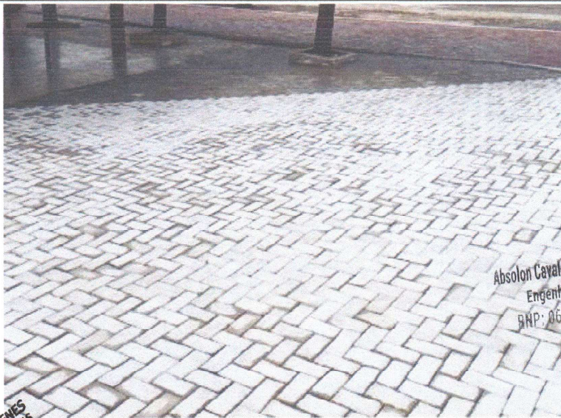
EXECUÇÃO DE PAVIMENTAÇÃO COM INTERTRAVADO
