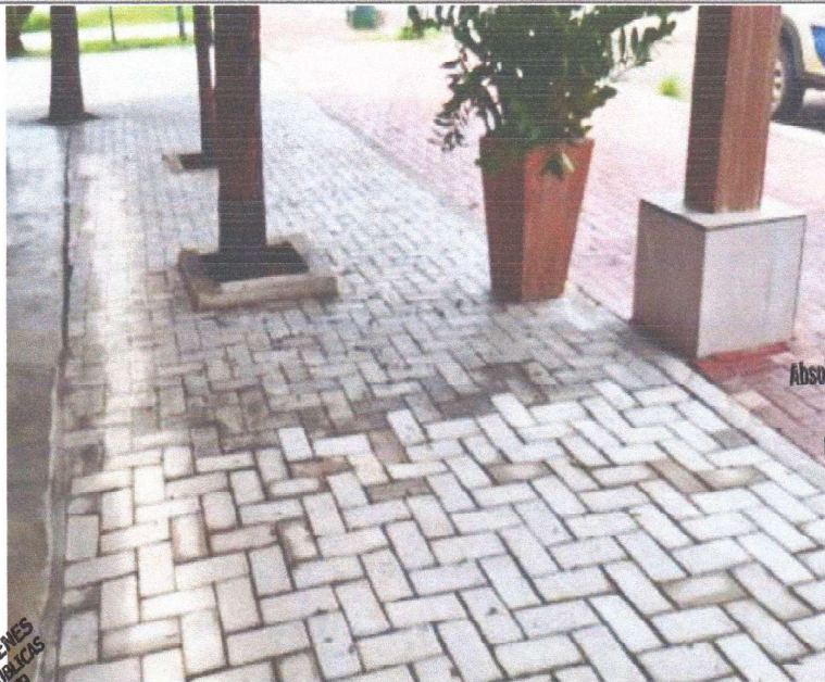
EXECUÇÃO DE PAVIMENTAÇÃO COM INTERTRAVADO
