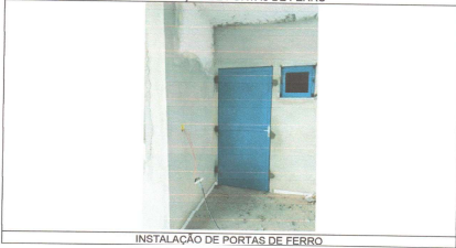
INSTALAÇÃO DE PORTAS DE FERRO
