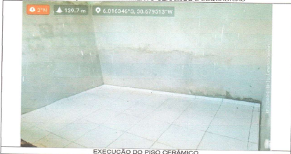
EXECUÇÃO DO PISO CERÂMICO
