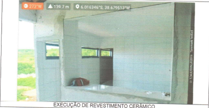
EXECUÇÃO DE REVESTIMENTO CERÂMICO
