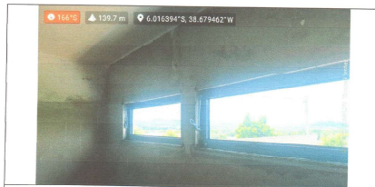
EXECUÇÃO DE ESQUADRIAS METÁLICAS
