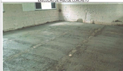
EXECUÇÃO DE PISO DE CONCRETO
