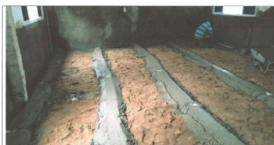
EXECUÇÃO DE PISO DE CONCRETO
