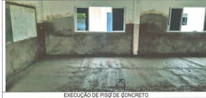
EXECUÇÃO DE PISO DE CONCRETO
