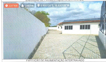
EXECUÇÃO DE PAVIMENTAÇÃO INTERTRAVADO
