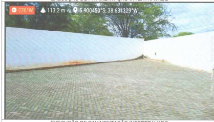
EXECUÇÃO DE PAVIMENTAÇÃO INTERTRAVADO
