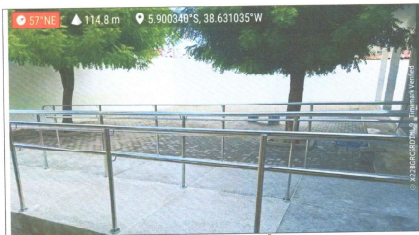
EXECUÇÃO DE CORRIMÃO
