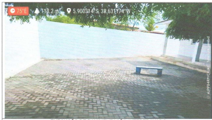
EXECUÇÃO DE PAVIMENTAÇÃO INTERTRAVADO
