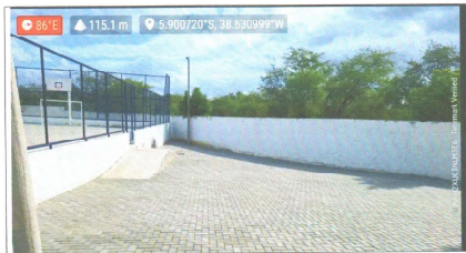
EXECUÇÃO DE PAVIMENTAÇÃO INTERTRAVADO
