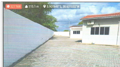
EXECUÇÃO DE PAVIMENTAÇÃO INTERTRAVADO
