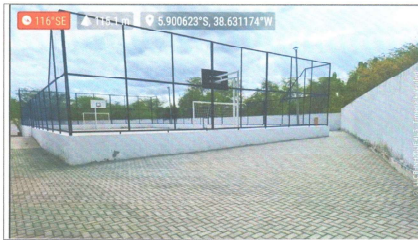
EXECUÇÃO DE PAVIMENTAÇÃO INTERTRAVADO
