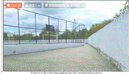
EXECUÇÃO DE PAVIMENTAÇÃO INTERTRAVADO
