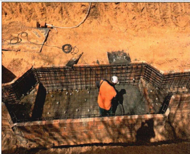
ARMAÇÃO DO AÇO E CONCRETAGEM DA CAIXA DE AREIA
