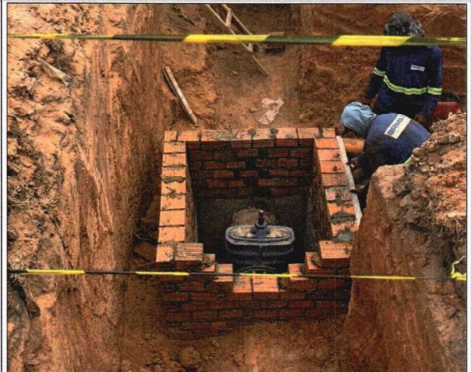
EXECUÇÃO DE CAIXA DE REGISTRO
