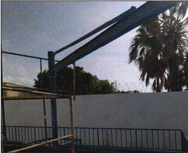
INSTALAÇÃO DE GRUA GIRATÓRIA
