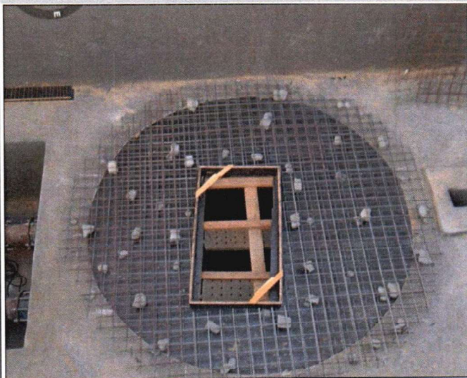
CONCRETAGEM DE TAMPA
