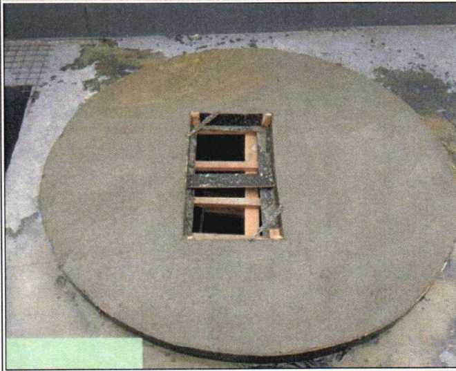
CONCRETAGEM DE TAMPA
