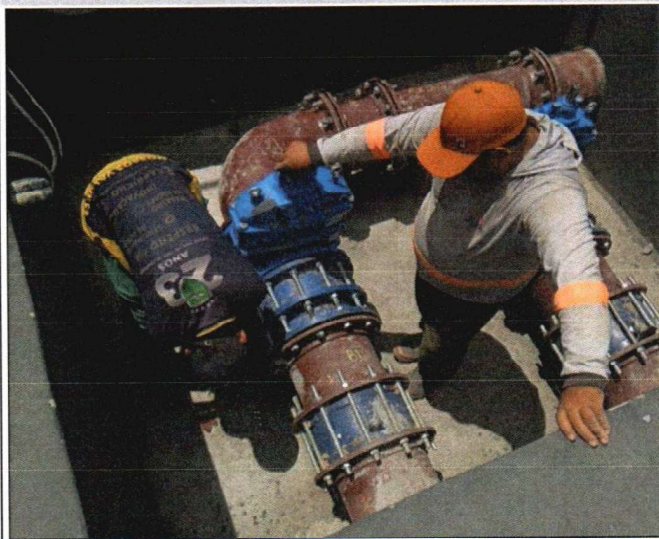
MONTAGEM DE TUBOS E CONEXÕES
