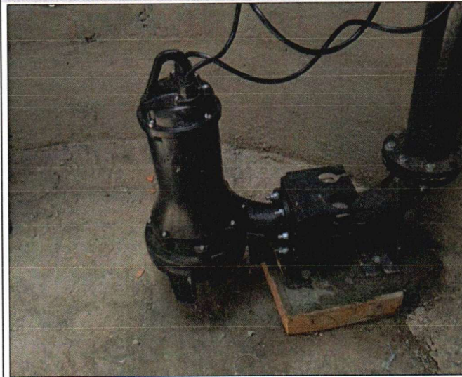
INSTALAÇÃO DE BOMBAS
