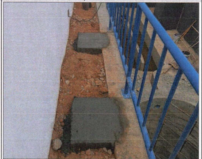
INSTALAÇÃO DE GUARDA-CORPO
