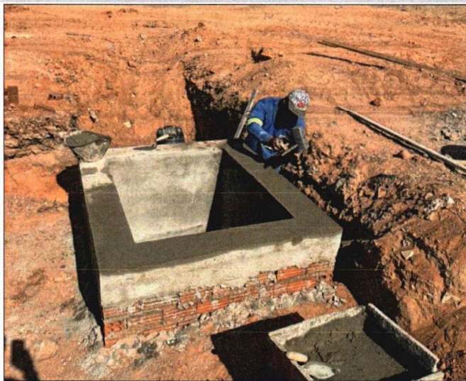
EXECUÇÃO DE CAIXA DE REGISTRO
