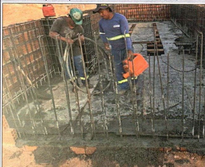
ARMAÇÃO DO AÇO E CONCRETAGEM DAS PAREDES LATERAIS
