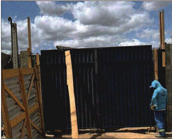
INSTALAÇÃO DE PORTÃO
