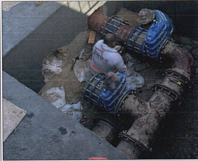
MONTAGEM DE TUBOS E CONEXÕES
