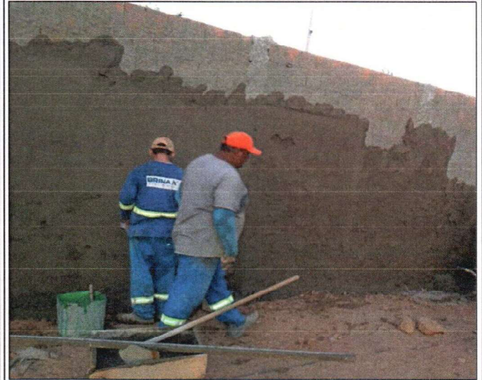
EXECUÇÃO DE MURO EM ALVENARIA
