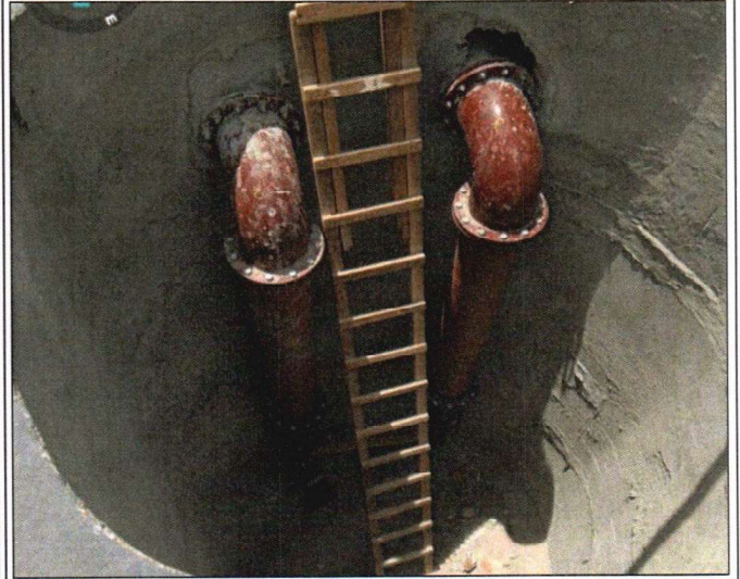
MONTAGEM DE TUBOS E CONEXÕES
