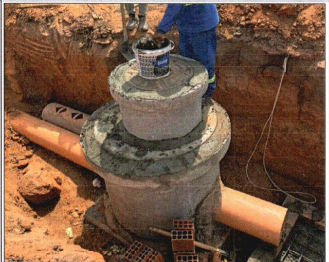
EXECUÇÃO DE CAIXA DE INSPEÇÃO
