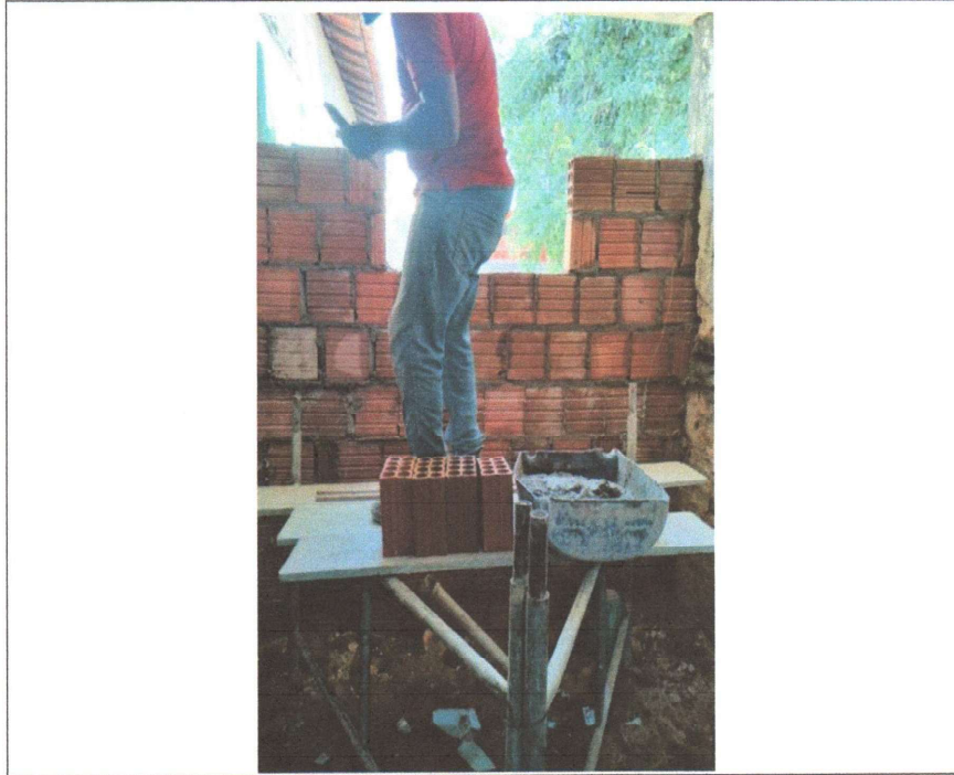
EXECUÇÃO DE ALVENARIA
