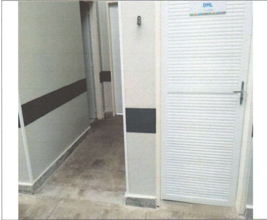
INSTALAÇÃO DE RODA-MEIO
