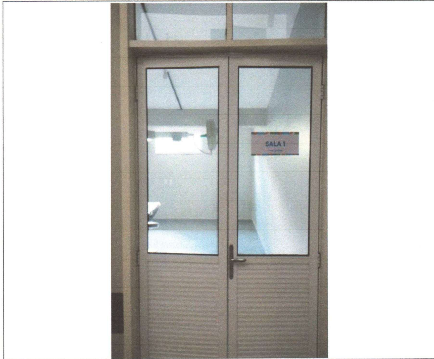
INSTALAÇÃO DE VIDRO NAS PORTAS
