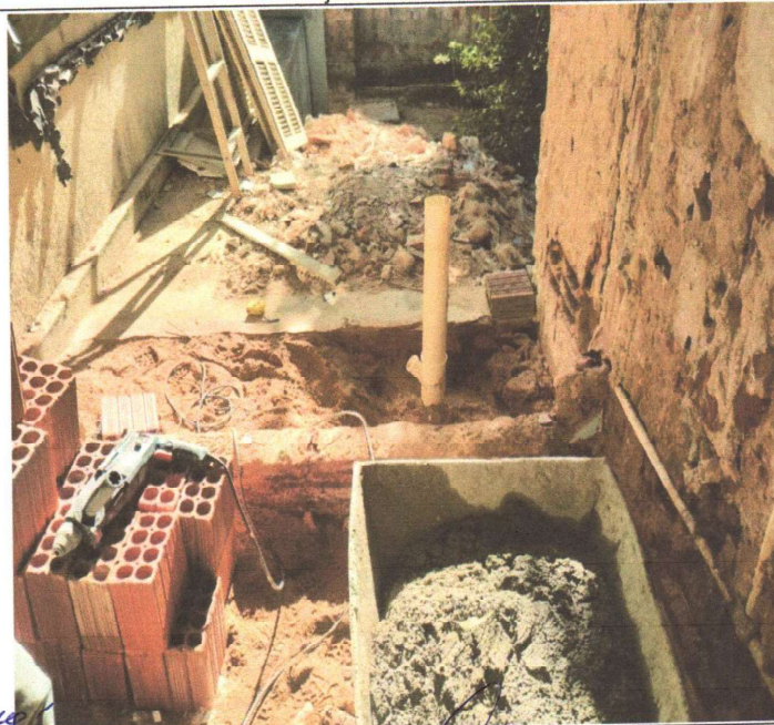
EXECUÇÃO DE ALVENARIA
