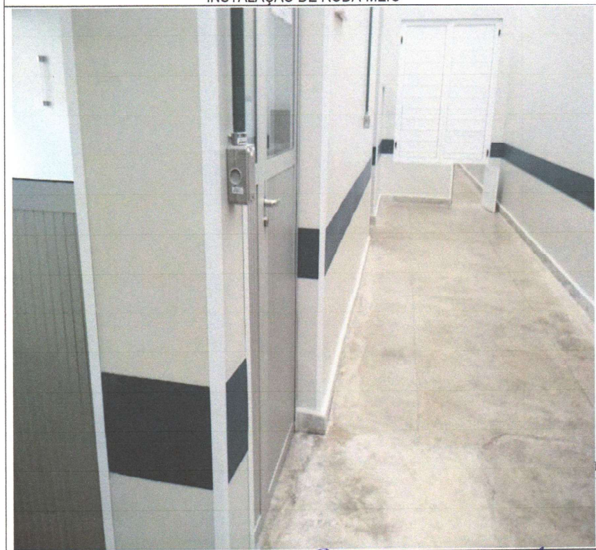
INSTALAÇÃO DE RODA-MEIO
