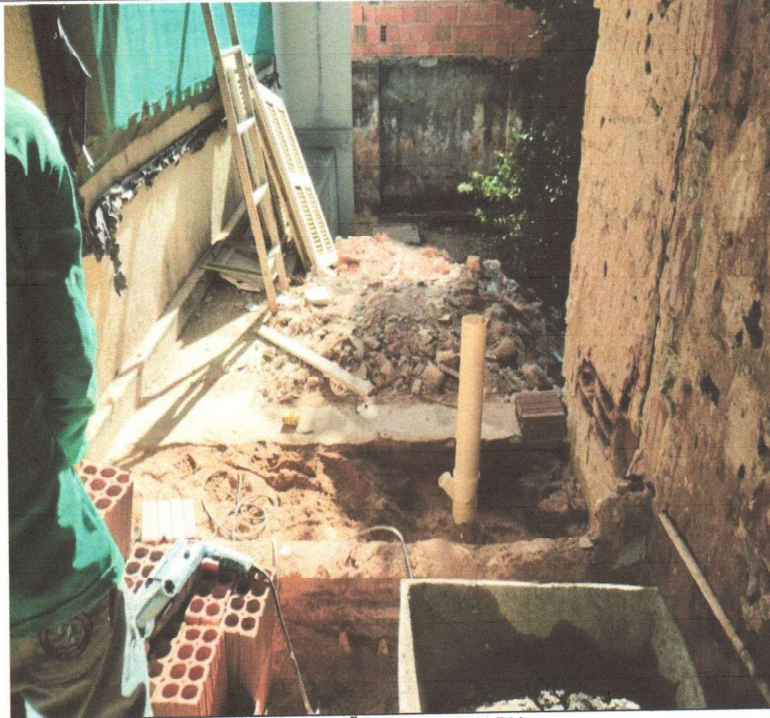
EXECUÇÃO DE ALVENARIA
