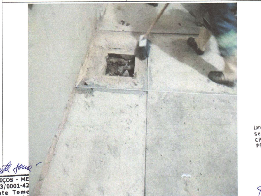
EXECUÇÃO DE PISO
