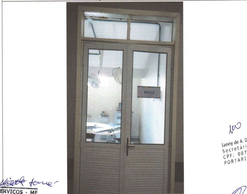
INSTALAÇÃO DE VIDRO NAS PORTAS
