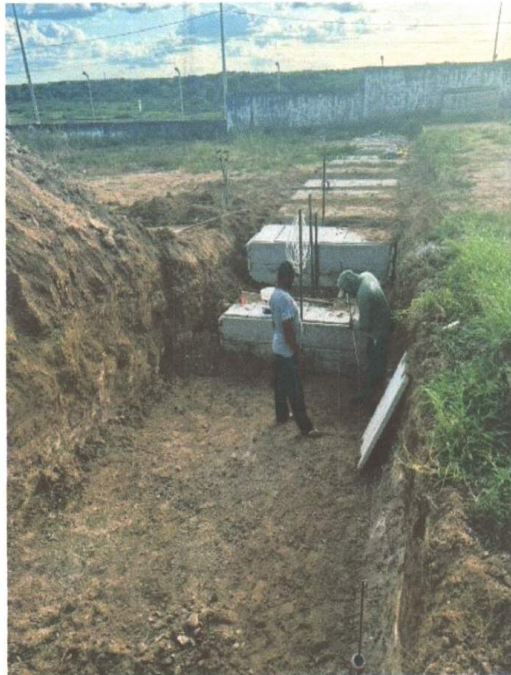
INSTALAÇÃO DAS PLACAS PRÉ MOLDADAS
