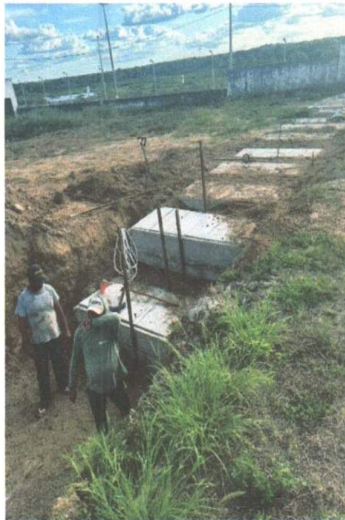
INSTALAÇÃO DAS PLACAS PRÉ MOLDADAS
