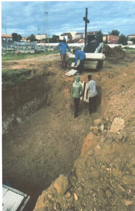
INSTALAÇÃO DAS PLACAS PRÉ MOLDADAS
