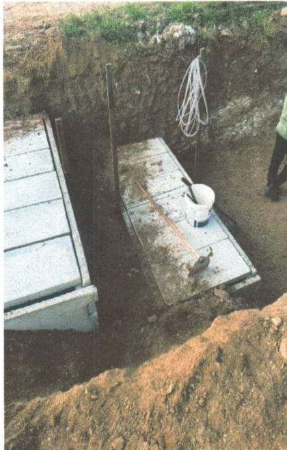
INSTALAÇÃO DAS PLACAS PRÉ MOLDADAS
