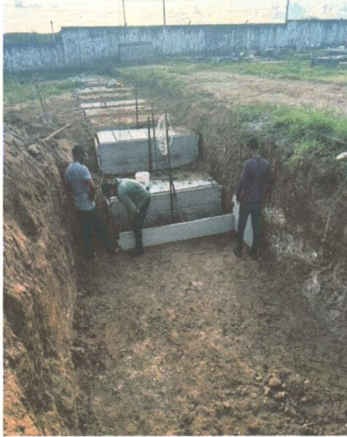
INSTALAÇÃO DAS PLACAS PRÉ MOLDADAS
