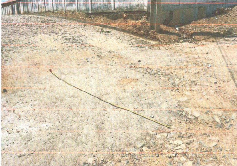
RECOMPOSIÇÃO DA PAVIMENTAÇÃO
