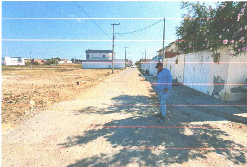
RECOMPOSIÇÃO DA PAVIMENTAÇÃO
