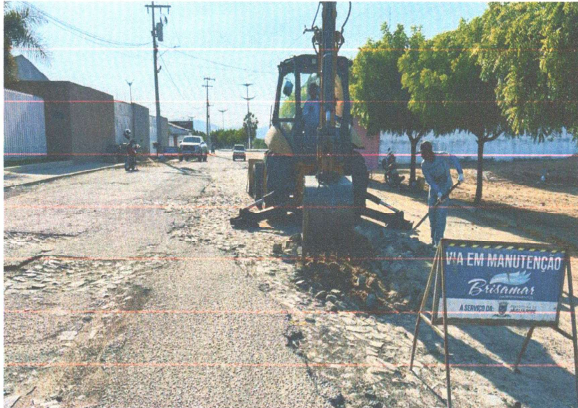
RECOMPOSIÇÃO DA PAVIMENTAÇÃO
