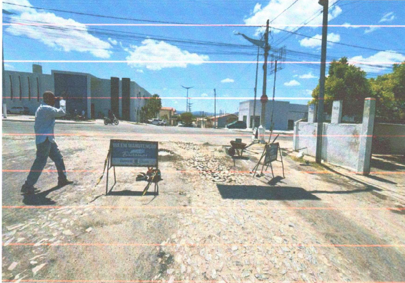
RECOMPOSIÇÃO DA PAVIMENTAÇÃO
