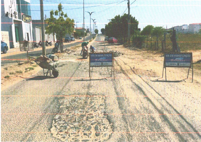
RECOMPOSIÇÃO DA PAVIMENTAÇÃO
