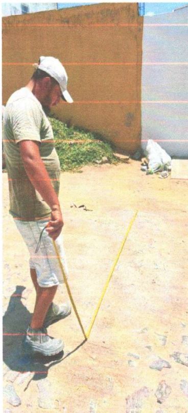
RECOMPOSIÇÃO DA PAVIMENTAÇÃO
