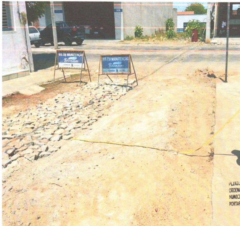
RECOMPOSIÇÃO DA PAVIMENTAÇÃO
