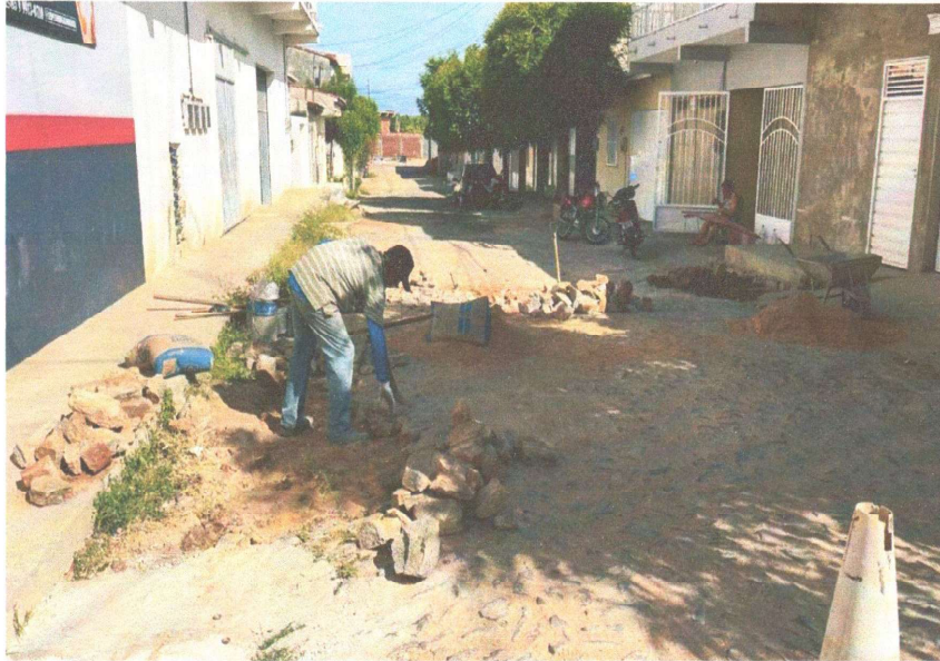
RECOMPOSIÇÃO DA PAVIMENTAÇÃO
