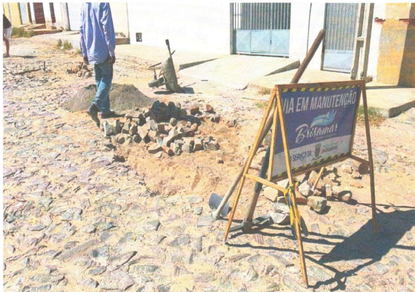
RECOMPOSIÇÃO DA PAVIMENTAÇÃO
