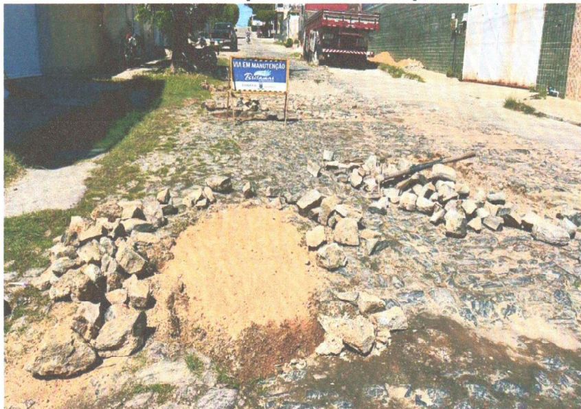
RECOMPOSIÇÃO DA PAVIMENTAÇÃO
