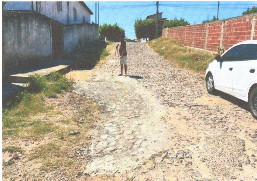
RECOMPOSIÇÃO DA PAVIMENTAÇÃO
