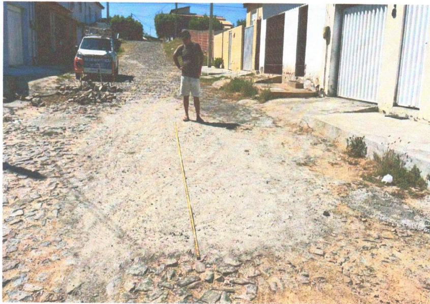
RECOMPOSIÇÃO DA PAVIMENTAÇÃO
