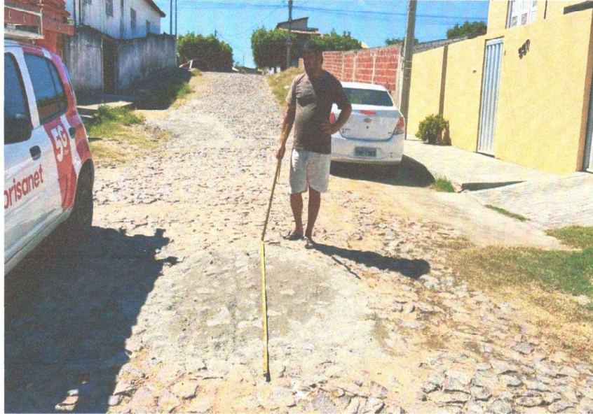
RECOMPOSIÇÃO DA PAVIMENTAÇÃO
