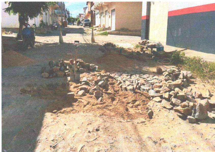
RECOMPOSIÇÃO DA PAVIMENTAÇÃO
