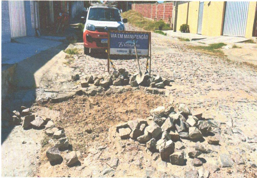
RECOMPOSIÇÃO DA PAVIMENTAÇÃO
