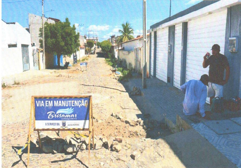
RECOMPOSIÇÃO DA PAVIMENTAÇÃO
