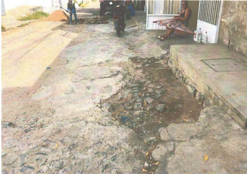
RECOMPOSIÇÃO DA PAVIMENTAÇÃO
