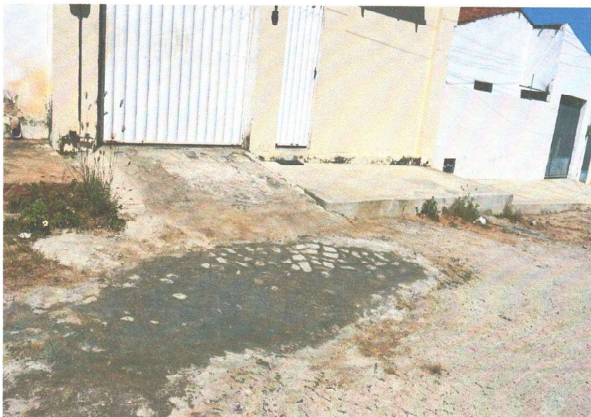
RECOMPOSIÇÃO DA PAVIMENTAÇÃO
