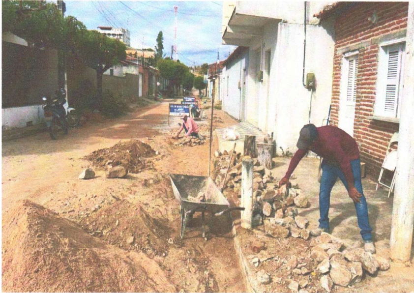
RECOMPOSIÇÃO DA PAVIMENTAÇÃO
