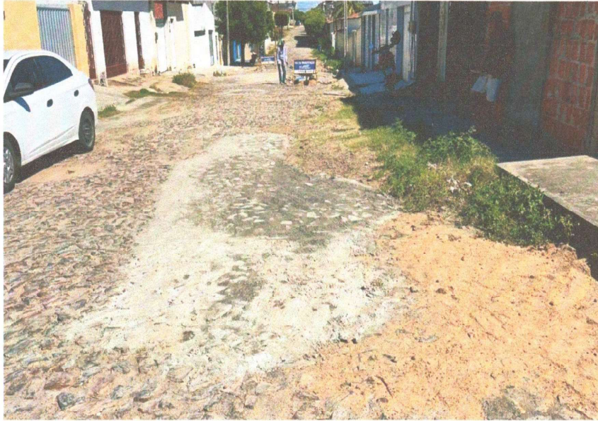
RECOMPOSIÇÃO DA PAVIMENTAÇÃO
