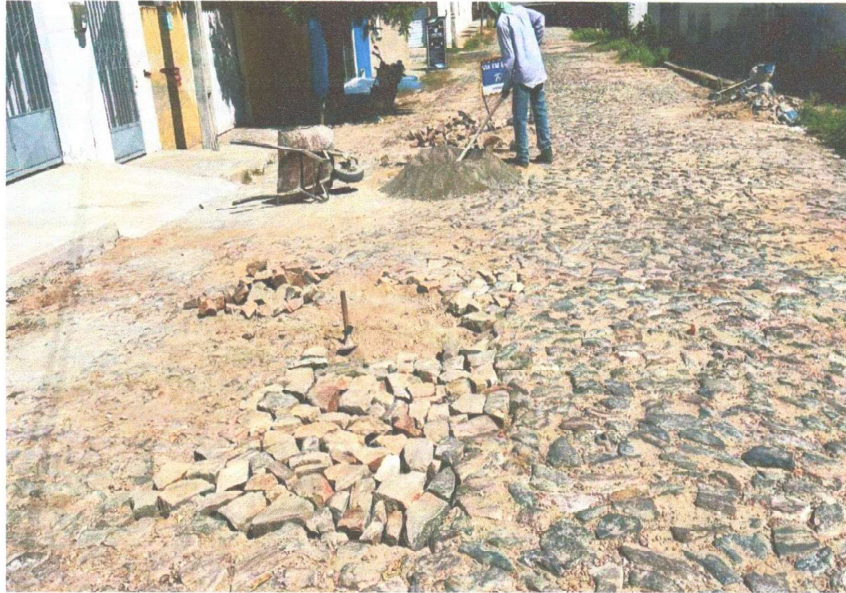
RECOMPOSIÇÃO DA PAVIMENTAÇÃO
