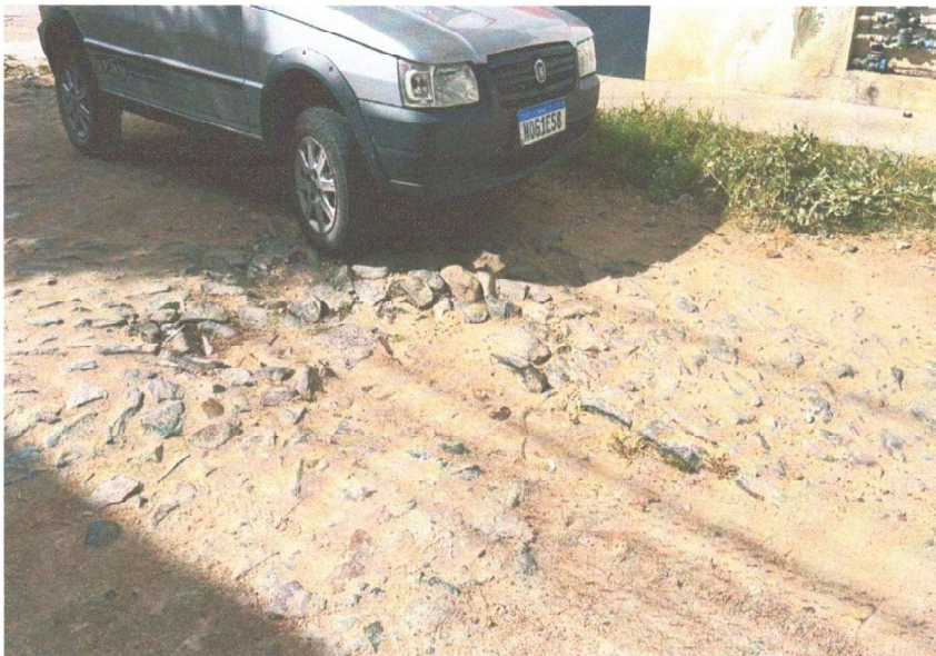
RECOMPOSIÇÃO DA PAVIMENTAÇÃO
