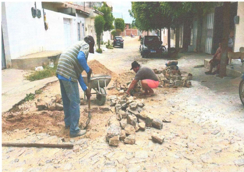
RECOMPOSIÇÃO DA PAVIMENTAÇÃO
