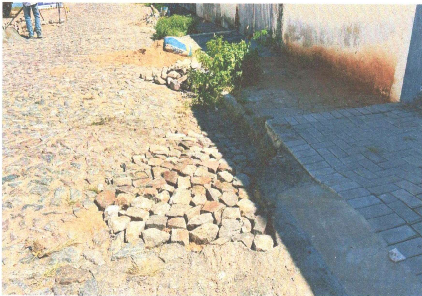
RECOMPOSIÇÃO DA PAVIMENTAÇÃO
