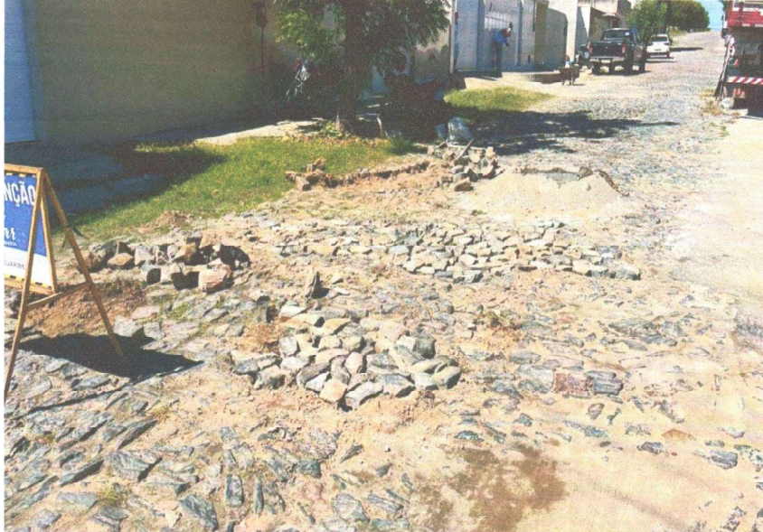
RECOMPOSIÇÃO DA PAVIMENTAÇÃO
