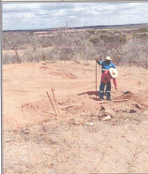
ESCAVAÇÃO MANUAL DE SOLO
