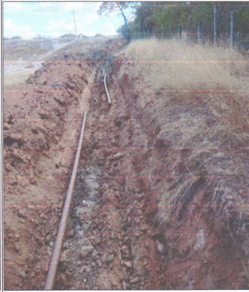
ESCAVAÇÃO DE VALA E ASSENTAMENTO DE TUBOS
