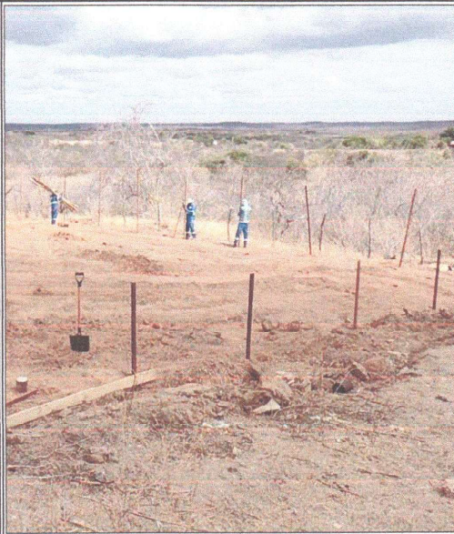
EXECUÇÃO DE GABARITO
