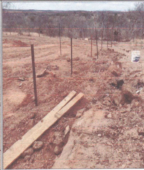
EXECUÇÃO DE GABARITO
