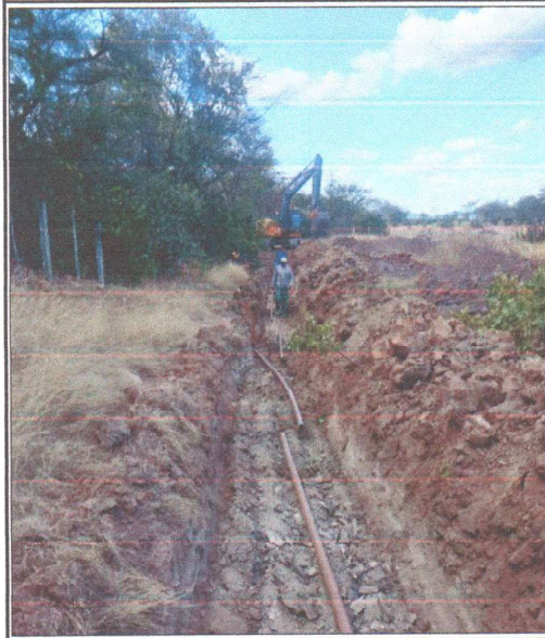
ESCAVAÇÃO DE VALA E ASSENTAMENTO DE TUBOS
