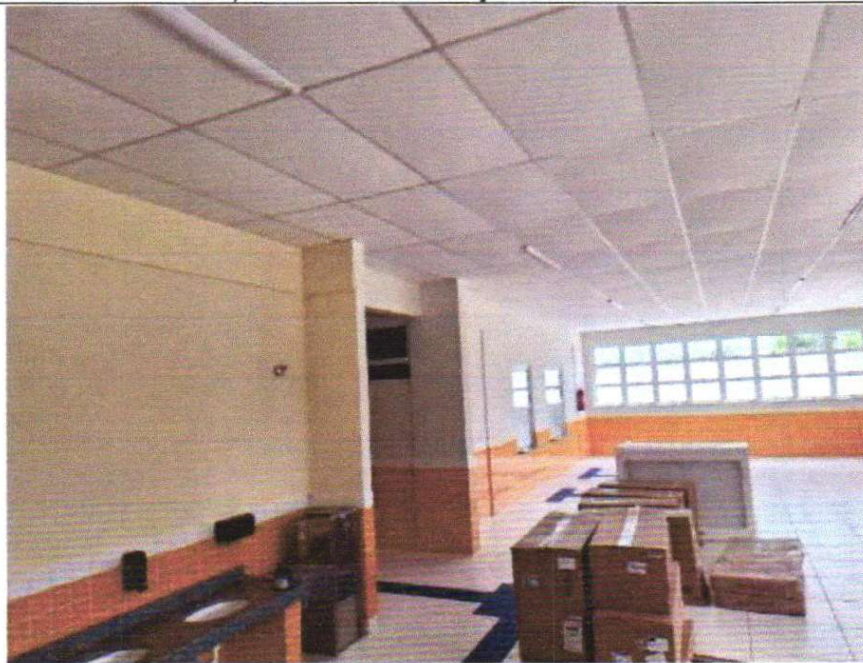
INSTALAÇÃO DE LUMINÁRIAS
