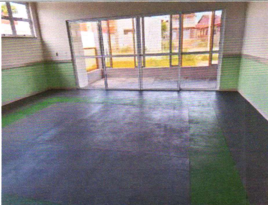
LIMPEZA FINAL DE OBRA
