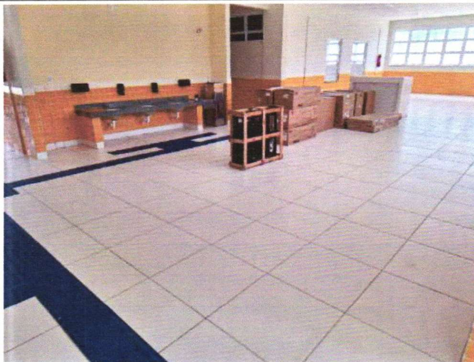
LIMPEZA FINAL PARA ENTREGA DE OBRA
