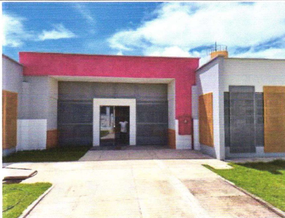
SERVIÇOS FINAIS DE OBRA
