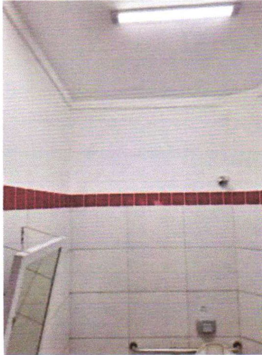
INSTALAÇÃO DE LUMINÁRIAS
