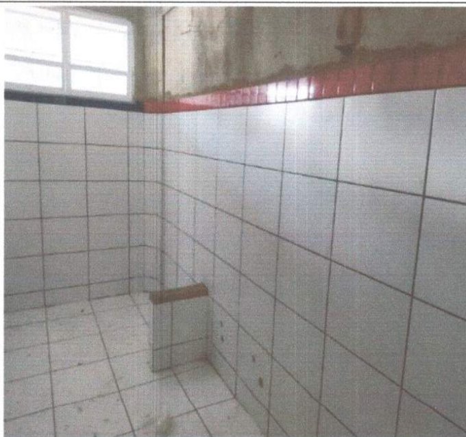
SERVIÇO DE EXECUÇÃO DE CERÂMICA.
