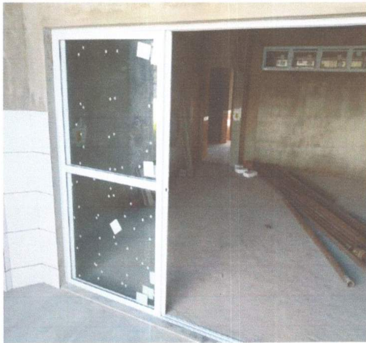
SERVIÇO DE EXECUÇÃO DE ESQUADRIAS.
