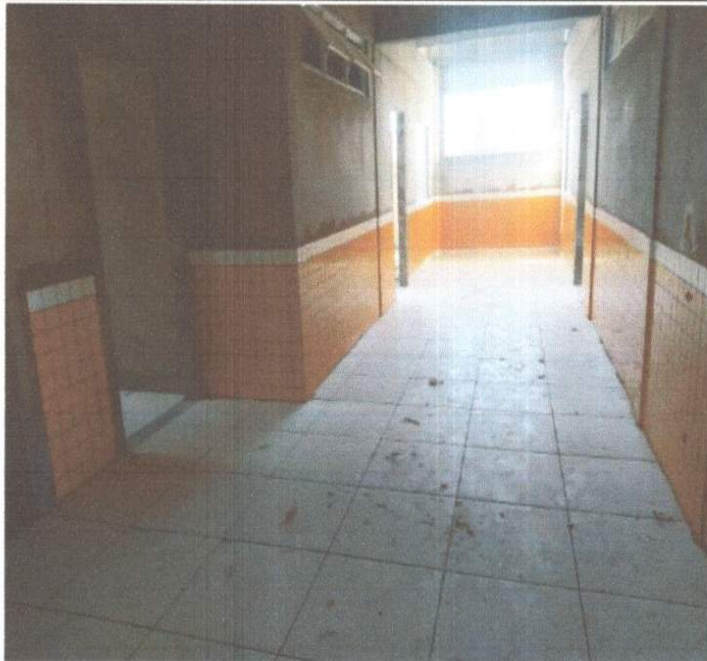
SERVIÇO DE EXECUÇÃO DE CERÂMICA.
