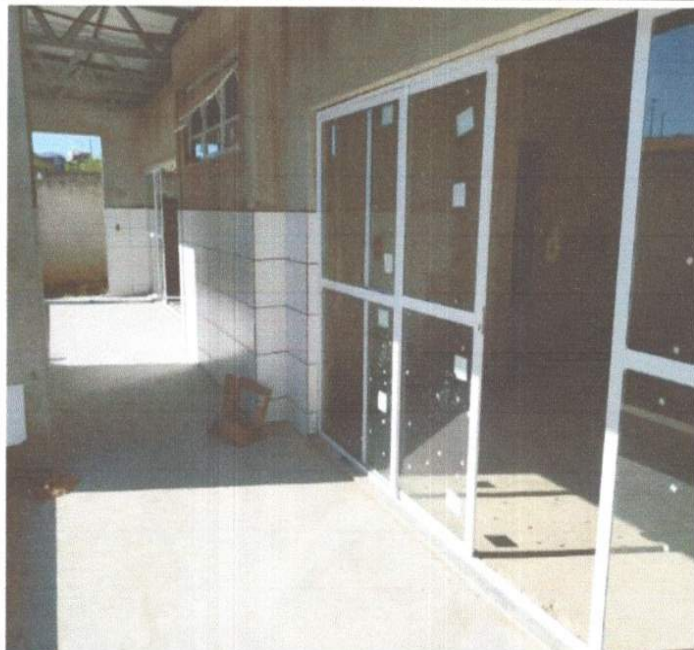
SERVIÇO DE EXECUÇÃO DE ESQUADRIAS.
