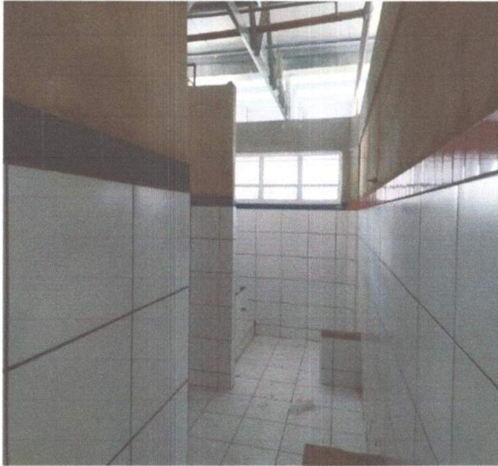
SERVIÇO DE EXECUÇÃO DE CERÂMICA.
