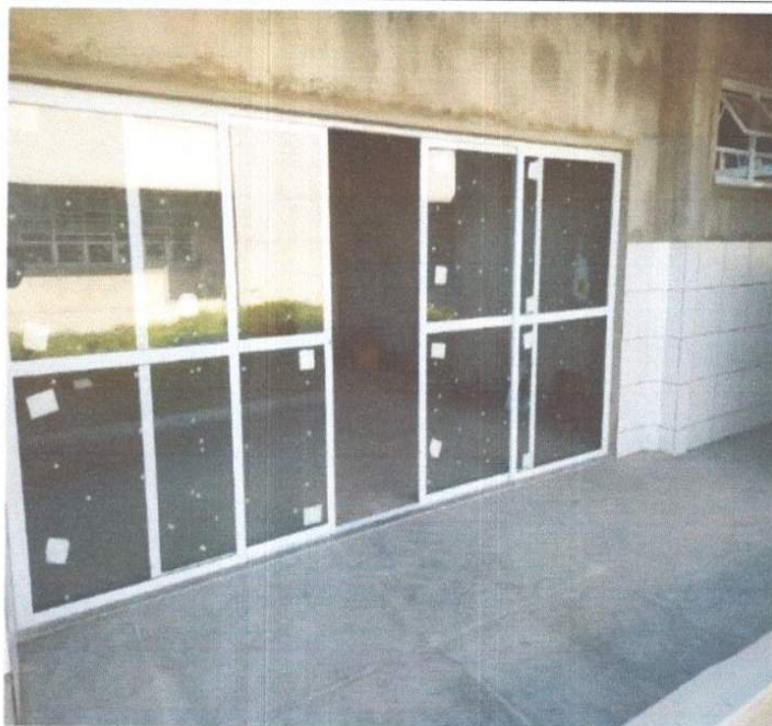
SERVIÇO DE EXECUÇÃO DE ESQUADRIAS.
