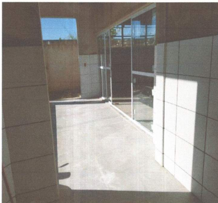
SERVIÇO DE EXECUÇÃO DE ESQUADRIAS.
