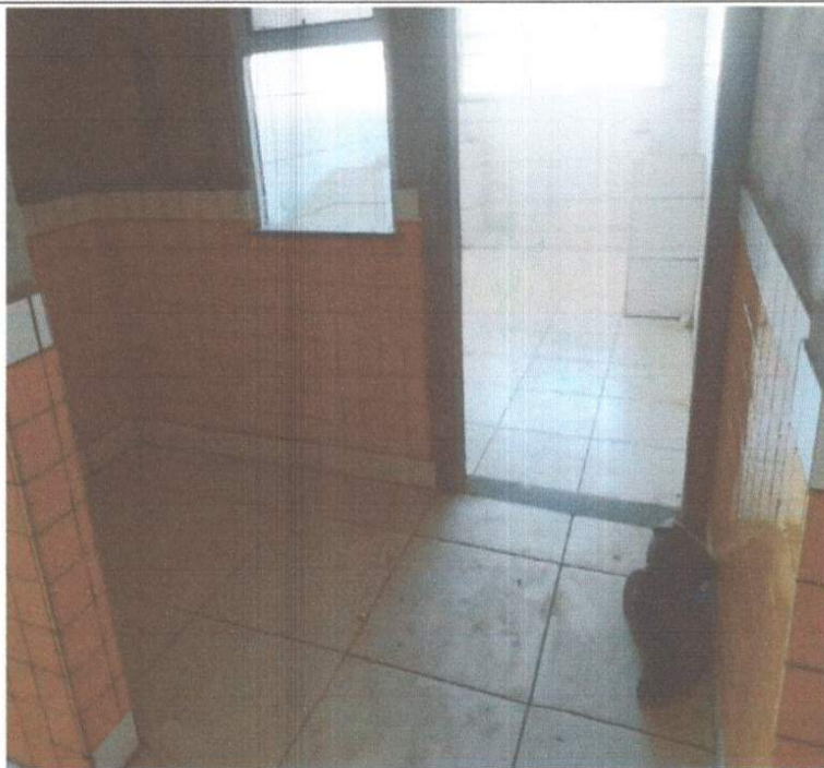
SERVIÇO DE EXECUÇÃO DE CERÂMICA.
