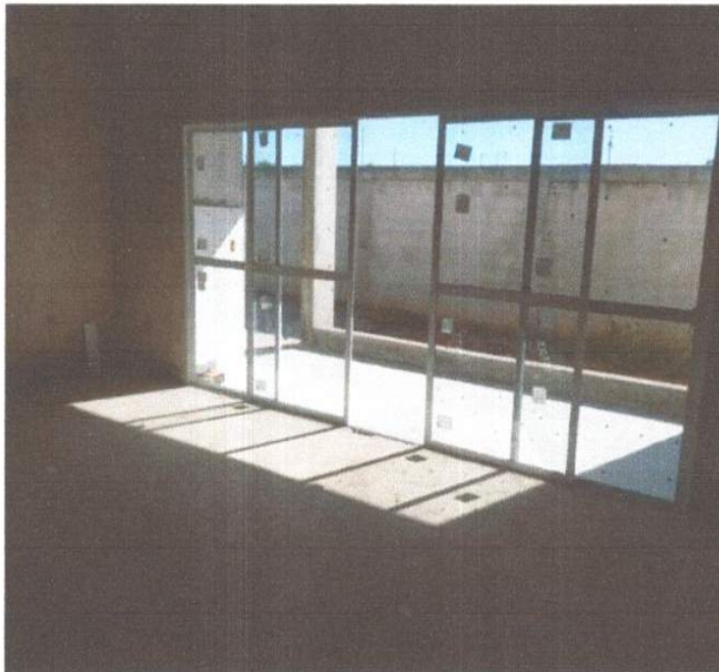
SERVIÇO DE EXECUÇÃO DE ESQUADRIAS.
