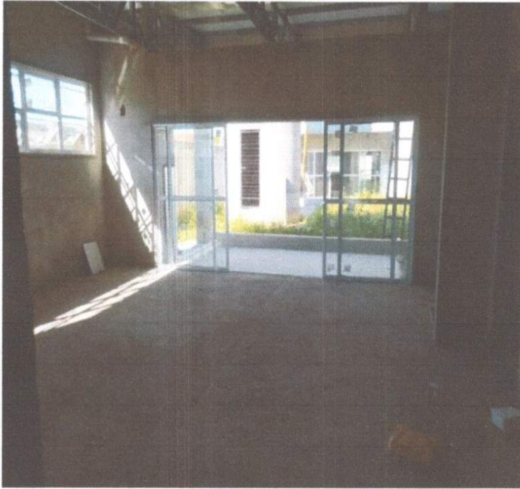
SERVIÇO DE EXECUÇÃO DE ESQUADRIAS.
