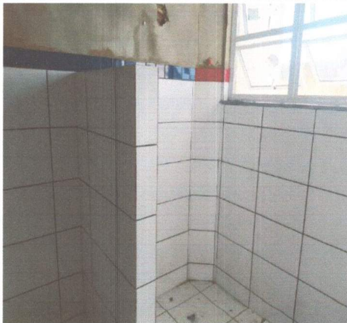
SERVIÇO DE EXECUÇÃO DE CERÂMICA.
