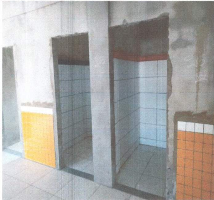
SERVIÇO DE EXECUÇÃO DE CERÂMICA.
