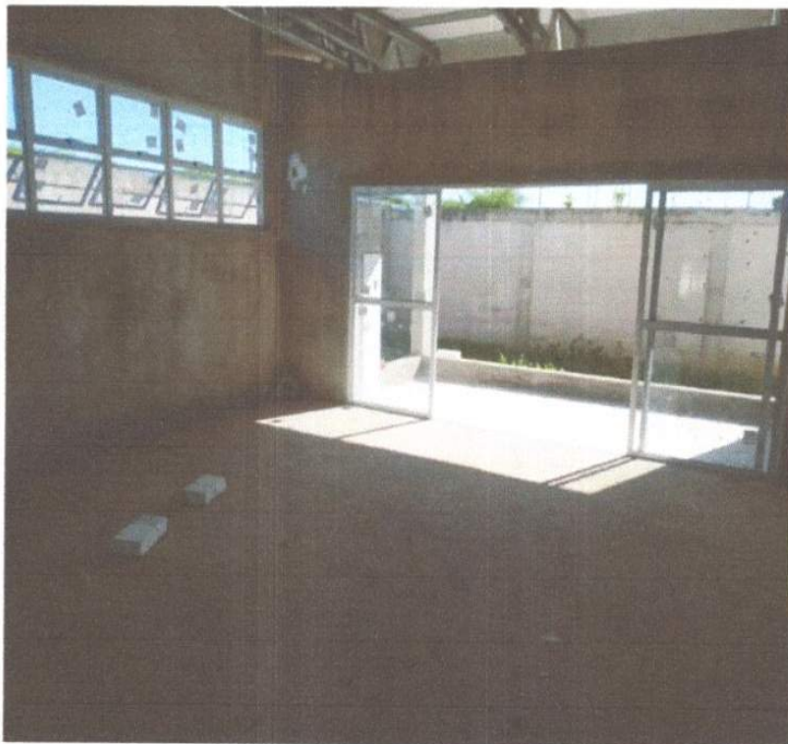
SERVIÇO DE EXECUÇÃO DE ESQUADRIAS.
