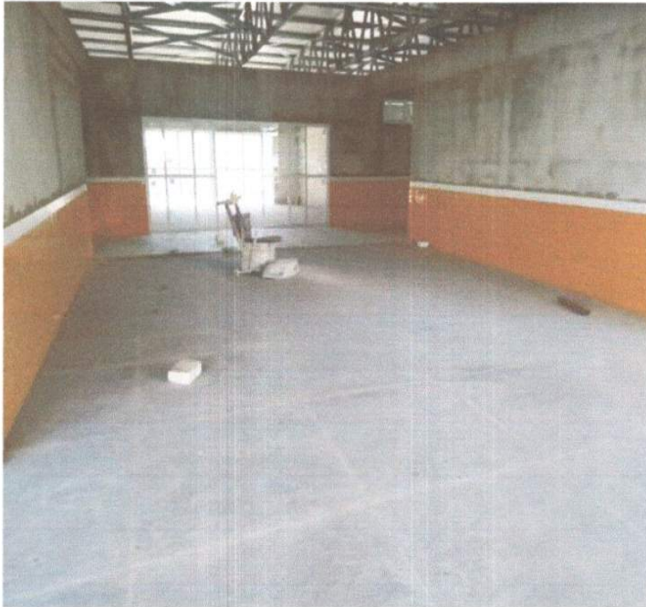
SERVIÇO DE EXECUÇÃO DE CERÂMICA.
