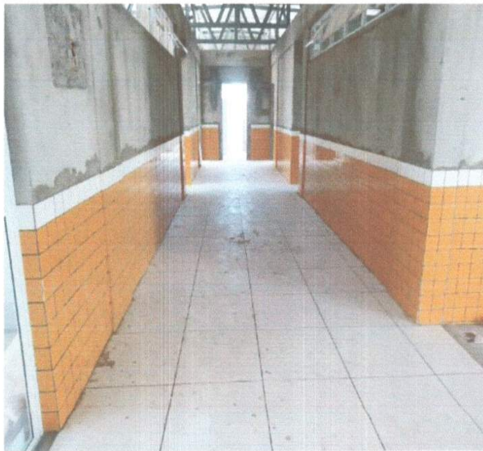
SERVIÇO DE EXECUÇÃO DE CERÂMICA.
