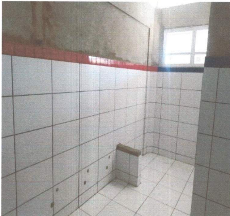
SERVIÇO DE EXECUÇÃO DE CERÂMICA.
