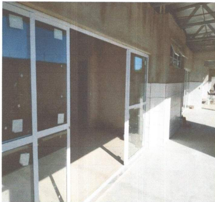
SERVIÇO DE EXECUÇÃO DE ESQUADRIAS.
