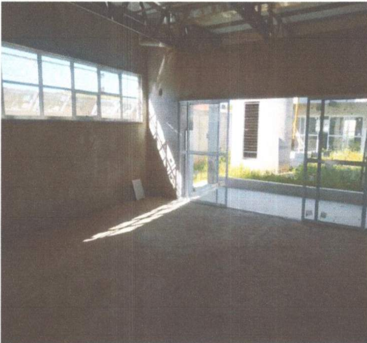
SERVIÇO DE EXECUÇÃO DE ESQUADRIAS.
