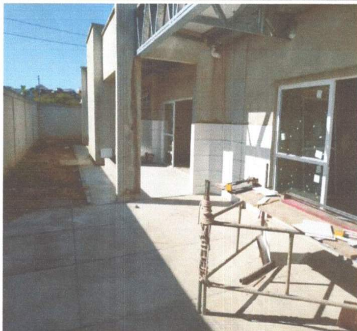
SERVIÇO DE EXECUÇÃO DE CERÂMICA E ESQUADRIAS.
