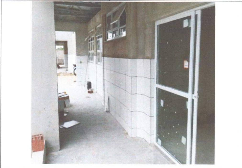
SERVIÇO DE EXECUÇÃO DE CERÂMICA.
