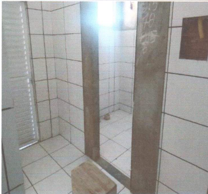
SERVIÇO DE EXECUÇÃO DE CERÂMICA.
