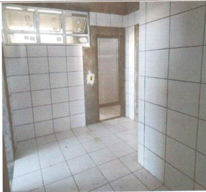
SERVIÇO DE EXECUÇÃO DE CERÂMICA.
