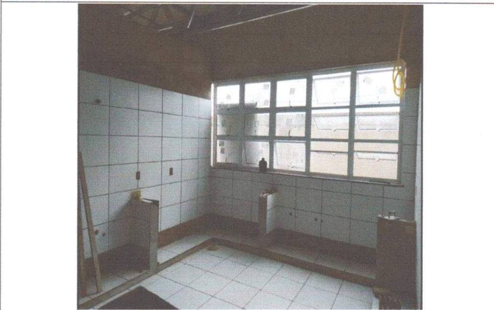
SERVIÇO DE EXECUÇÃO DE CERÂMICA.
