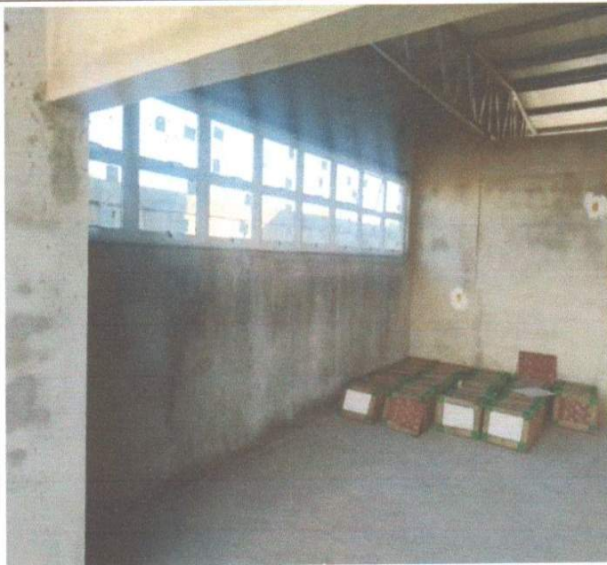
SERVIÇO DE INSTALAÇÃO DE ESQUADRIAS.
