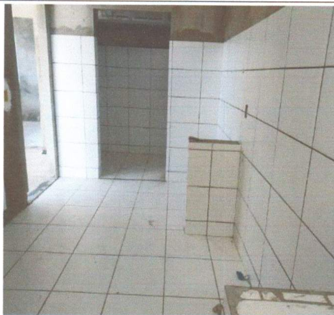
SERVIÇO DE EXECUÇÃO DE CERÂMICA.
