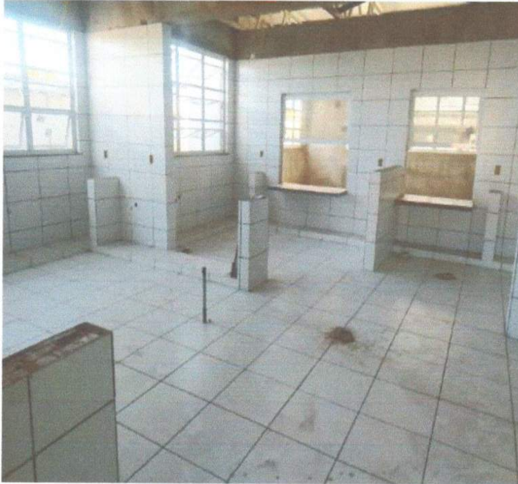
SERVIÇO DE EXECUÇÃO DE CERÂMICA.
