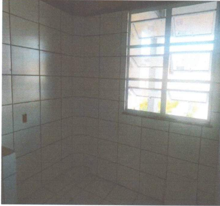
SERVIÇO DE EXECUÇÃO DE CERÂMICA.
