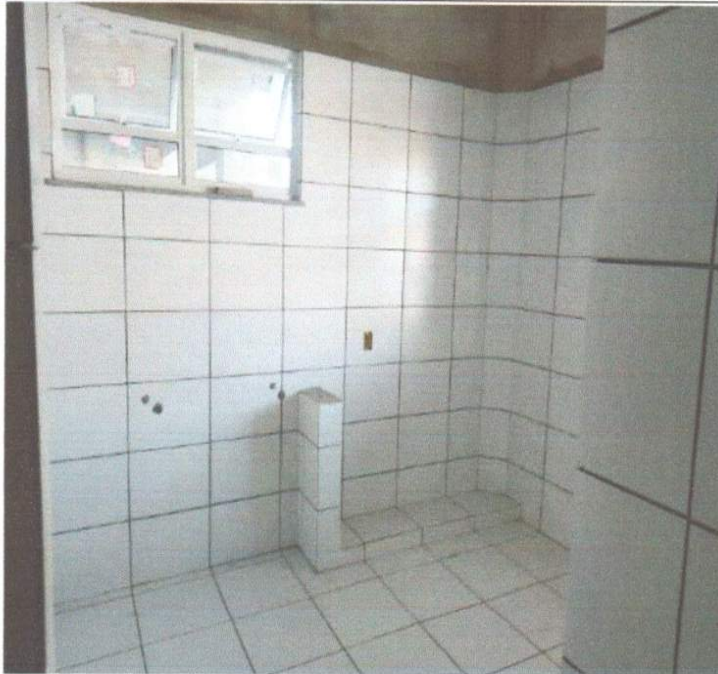
SERVIÇO DE EXECUÇÃO DE CERÂMICA.
