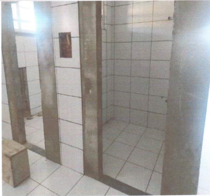
SERVIÇO DE EXECUÇÃO DE CERÂMICA.
