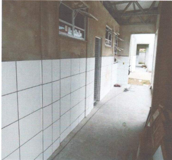
SERVIÇO DE EXECUÇÃO DE CERÂMICA.
