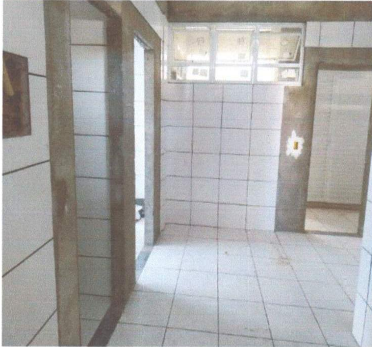
SERVIÇO DE EXECUÇÃO DE CERÂMICA.
