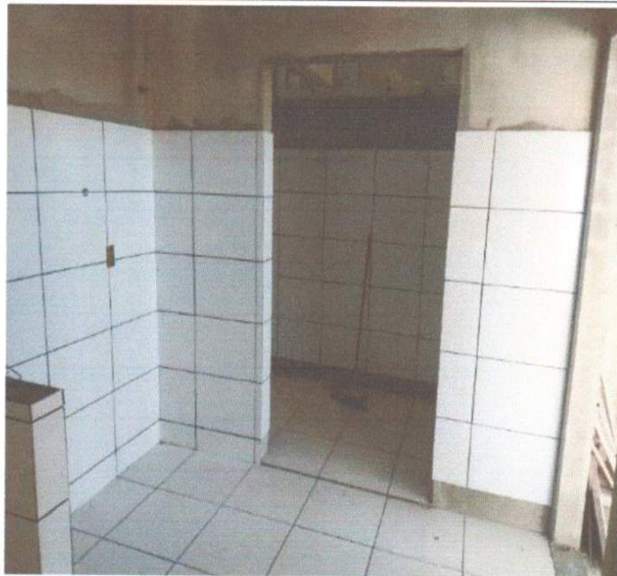
SERVIÇO DE EXECUÇÃO DE CERÂMICA.
