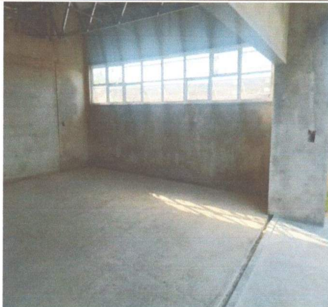
SERVIÇO DE INSTALAÇÃO DE ESQUADRIAS.
