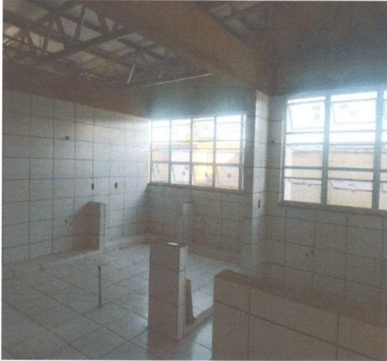
SERVIÇO DE EXECUÇÃO DE CERÂMICA.
