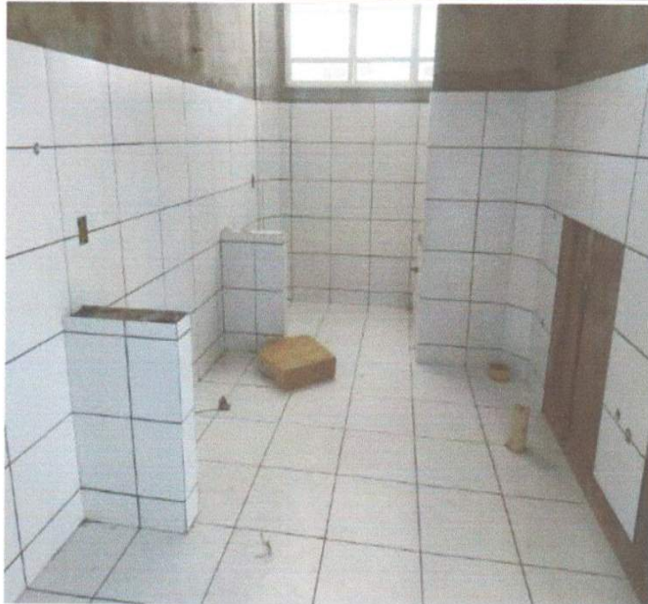
SERVIÇO DE EXECUÇÃO DE CERÂMICA.
