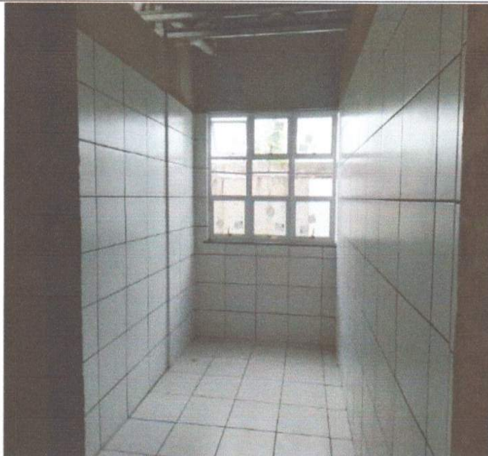
SERVIÇO DE EXECUÇÃO DE CERÂMICA.
