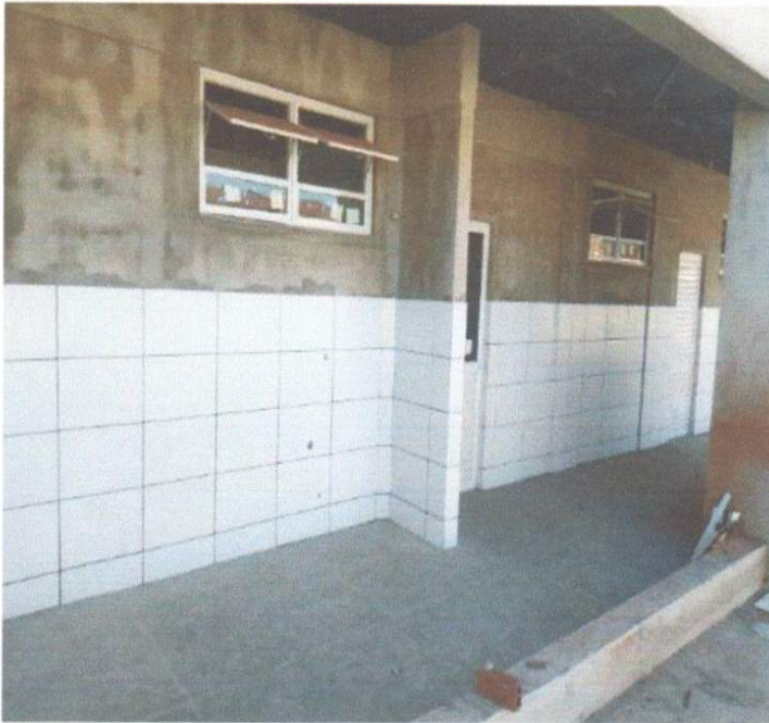
SERVIÇO DE EXECUÇÃO DE CERÂMICA.
