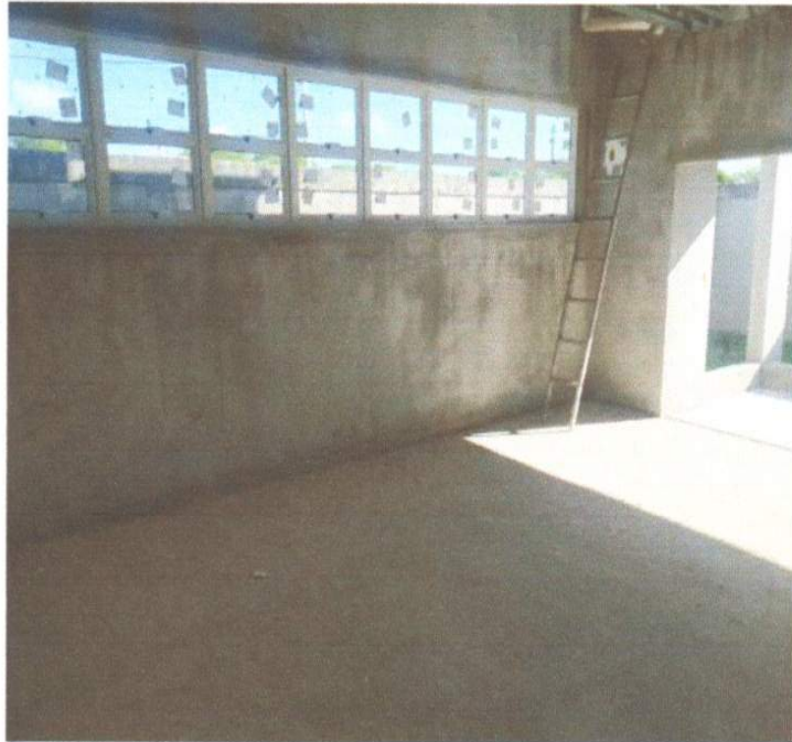
SERVIÇO DE INSTALAÇÃO DE ESQUADRIAS.
