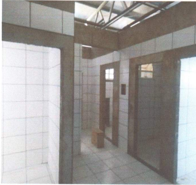
SERVIÇO DE EXECUÇÃO DE CERÂMICA.
