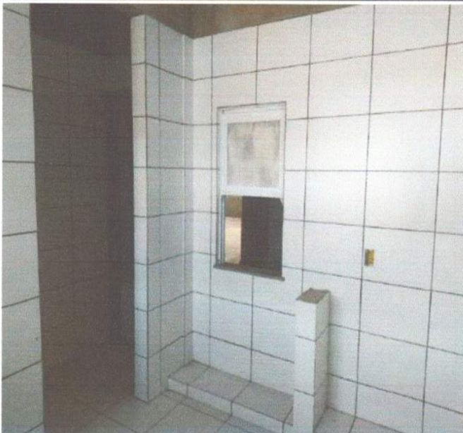
SERVIÇO DE EXECUÇÃO DE CERÂMICA.
