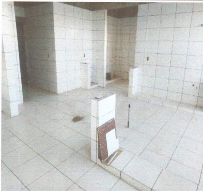
SERVIÇO DE EXECUÇÃO DE CERÂMICA.
