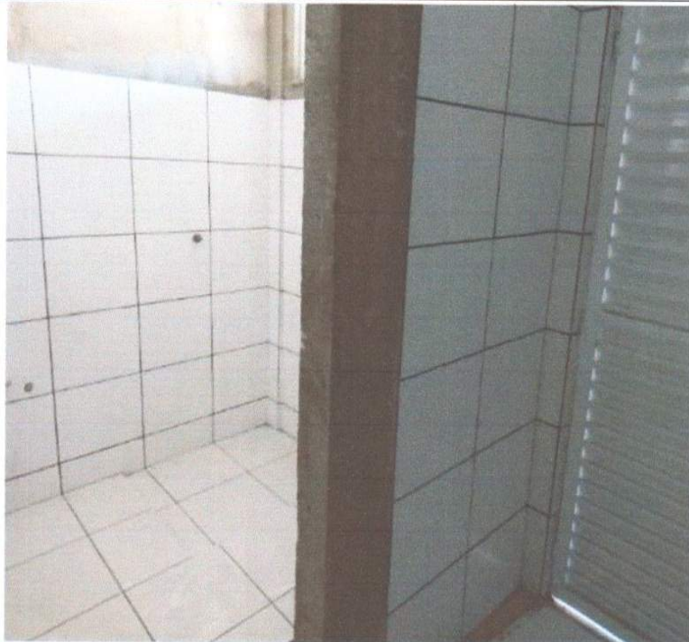
SERVIÇO DE EXECUÇÃO DE CERÂMICA.
