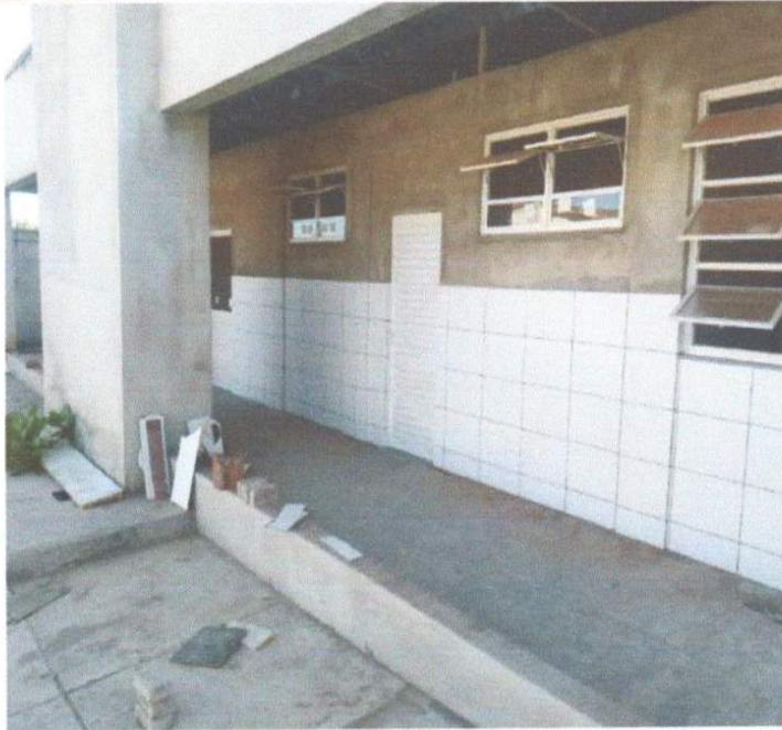
SERVIÇO DE EXECUÇÃO DE CERÂMICA.
