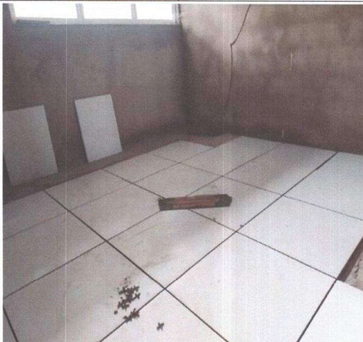
SERVIÇO DE EXECUÇÃO DE CERÂMICA.
