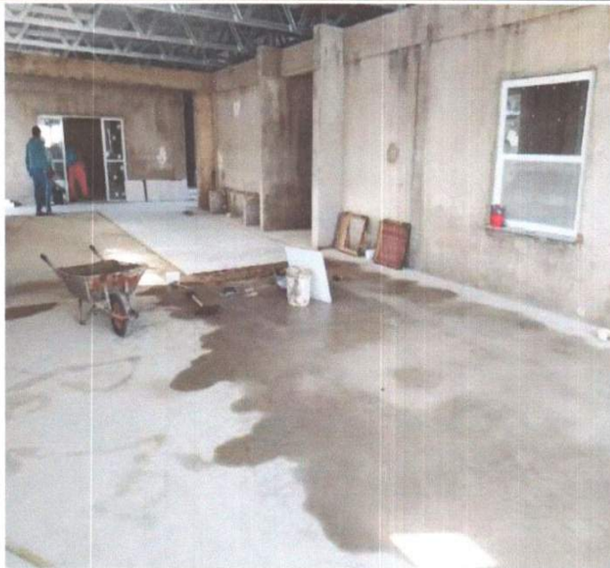
SERVIÇO DE EXECUÇÃO DE CERÂMICA.
