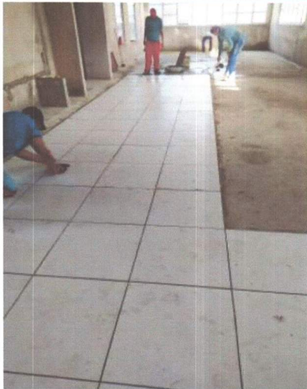
SERVIÇO DE EXECUÇÃO DE CERÂMICA.
