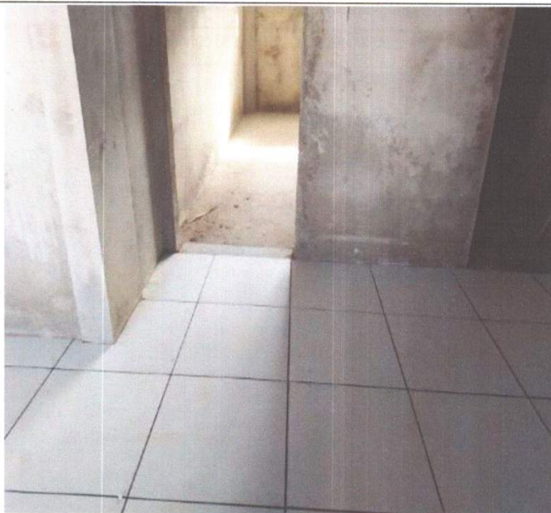
SERVIÇO DE EXECUÇÃO DE CERÂMICA.
