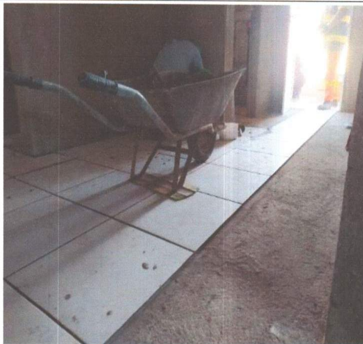
SERVIÇO DE EXECUÇÃO DE CERÂMICA.
