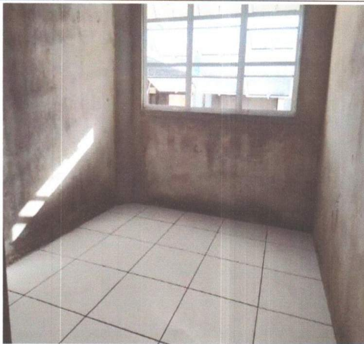
SERVIÇO DE EXECUÇÃO DE CERÂMICA.
