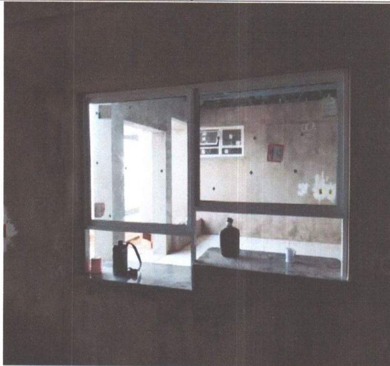
SERVIÇO DE INSTALAÇÃO DE ESQUADRIAS.
