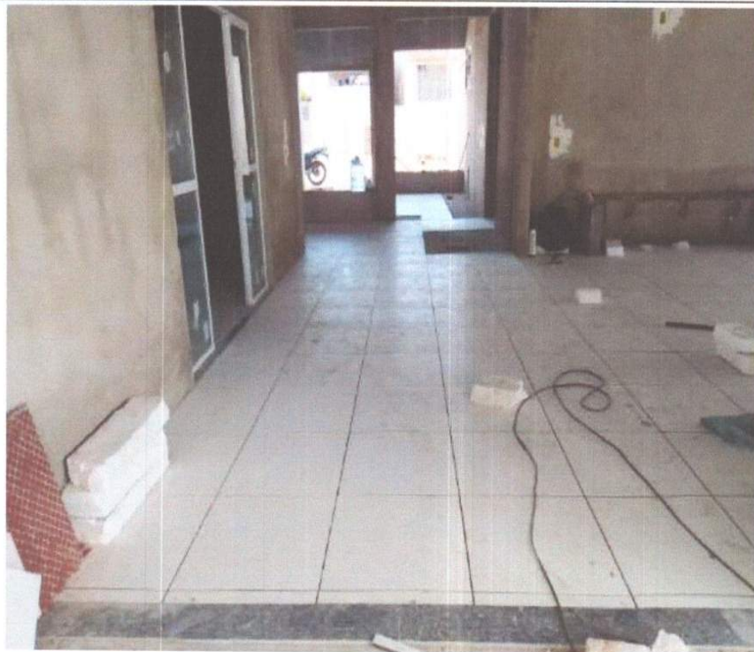
SERVIÇO DE EXECUÇÃO DE CERÂMICA.
