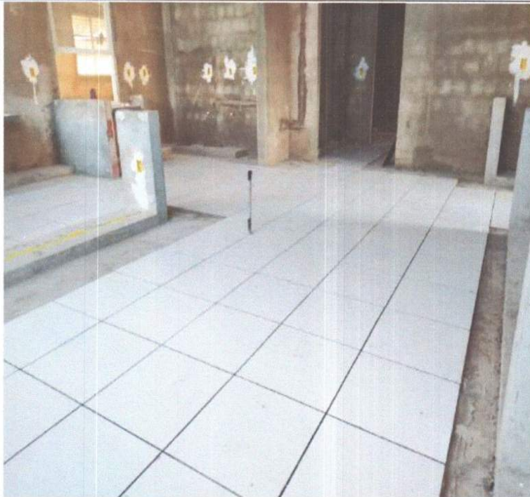
SERVIÇO DE EXECUÇÃO DE CERÂMICA.
