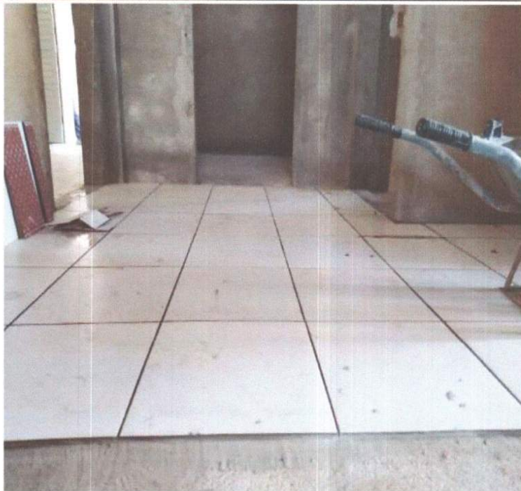
SERVIÇO DE EXECUÇÃO DE CERÂMICA.
