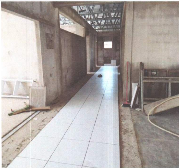
SERVIÇO DE EXECUÇÃO DE CERÂMICA.
