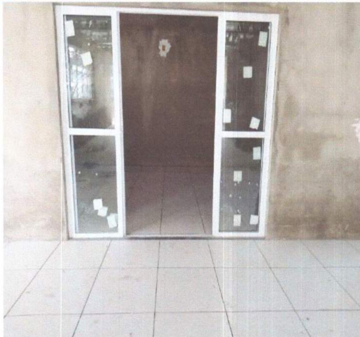
SERVIÇO DE EXECUÇÃO DE CERÂMICA.
