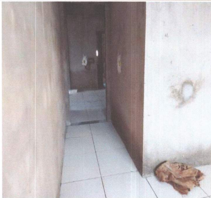
SERVIÇO DE EXECUÇÃO DE CERÂMICA.
