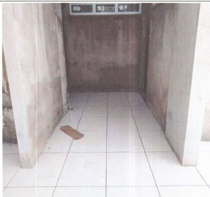
SERVIÇO DE EXECUÇÃO DE CERÂMICA.
