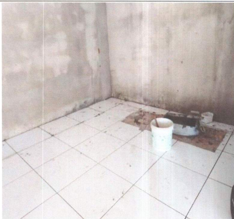
SERVIÇO DE EXECUÇÃO DE CERÂMICA.
