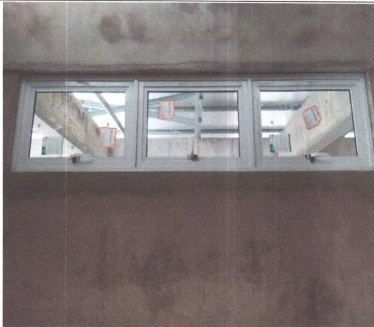
SERVIÇO DE INSTALAÇÃO DE ESQUADRIAS.
