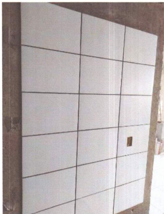
SERVIÇO DE EXECUÇÃO DE CERÂMICA.
