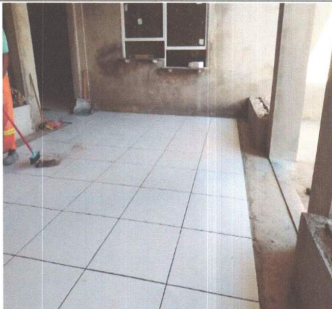
SERVIÇO DE EXECUÇÃO DE CERÂMICA.
