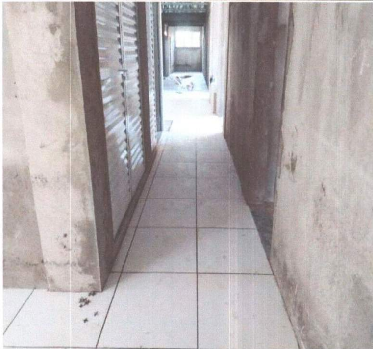
SERVIÇO DE EXECUÇÃO DE CERÂMICA.
