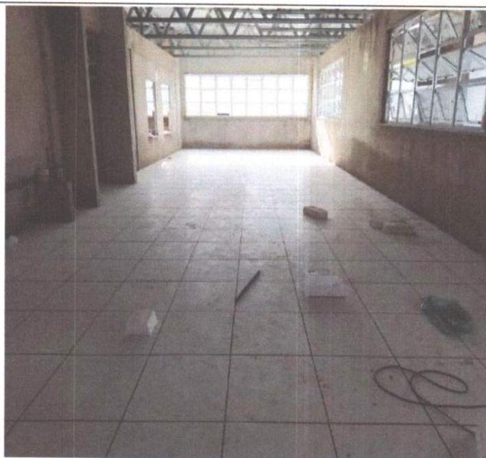
SERVIÇO DE EXECUÇÃO DE CERÂMICA.
