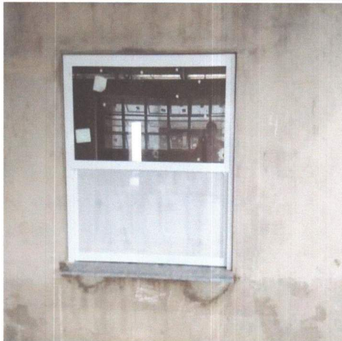
SERVIÇO DE INSTALAÇÃO DE ESQUADRIAS.
