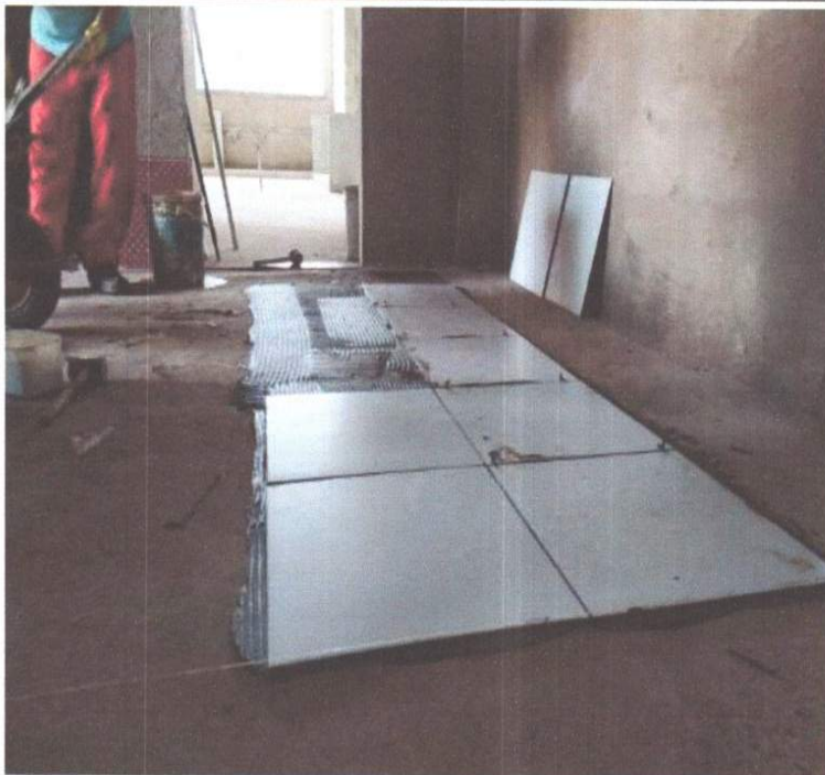
SERVIÇO DE EXECUÇÃO DE CERÂMICA.
