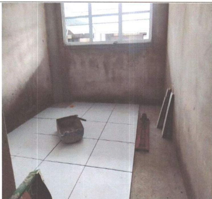
SERVIÇO DE EXECUÇÃO DE CERÂMICA.
