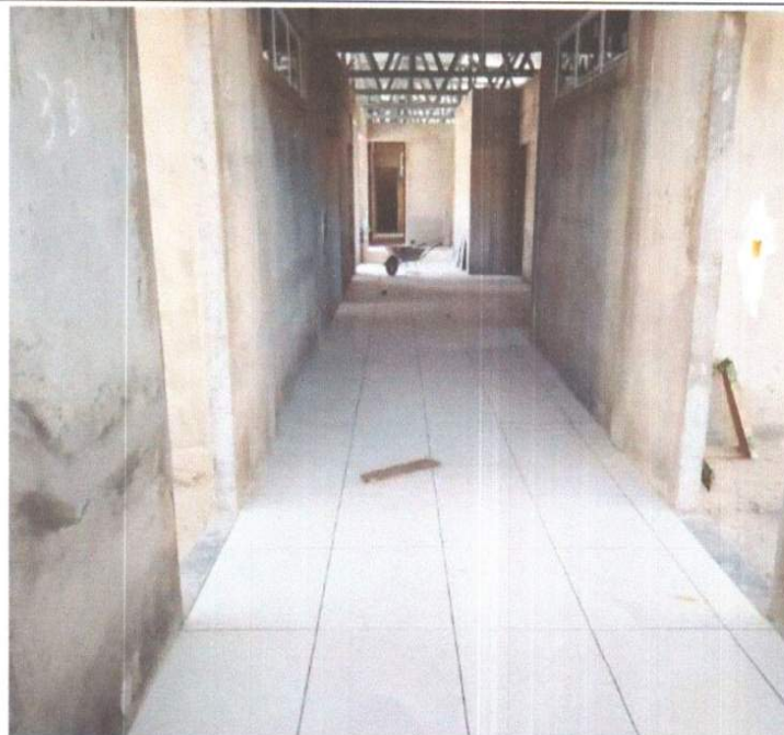
SERVIÇO DE EXECUÇÃO DE CERÂMICA.
