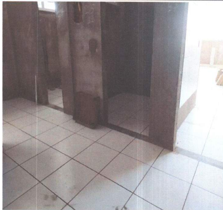
SERVIÇO DE EXECUÇÃO DE CERÂMICA.
