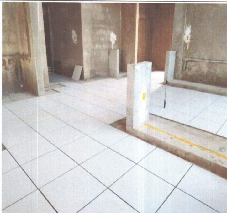
SERVIÇO DE EXECUÇÃO DE CERÂMICA.
