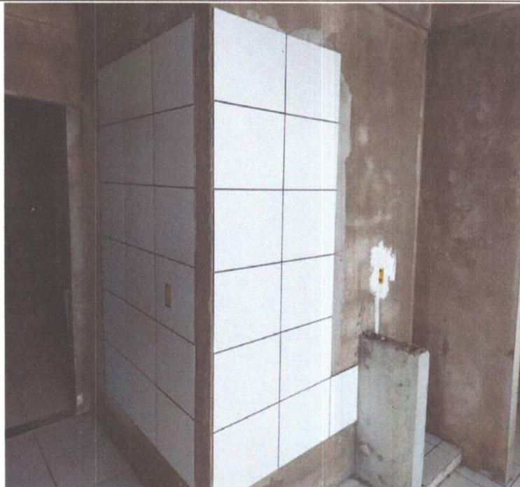
SERVIÇO DE EXECUÇÃO DE CERÂMICA.
