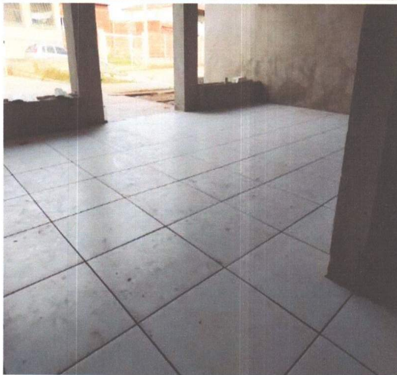
SERVIÇO DE EXECUÇÃO DE CERÂMICA.
