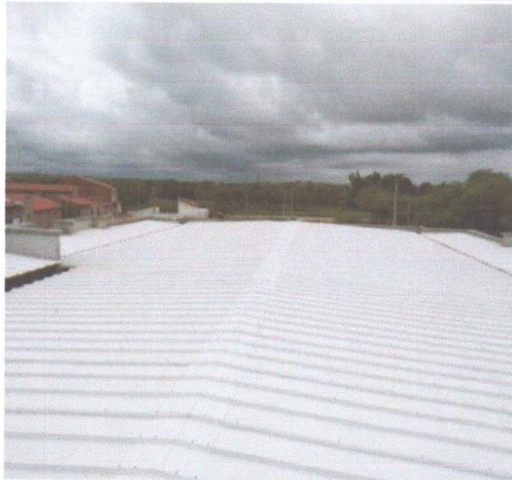
SERVIÇO DE EXECUÇÃO DE COBERTURA COM TELHA SANDUÍCHE.
