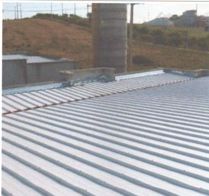
SERVIÇO DE EXECUÇÃO DE RUFO EM CHAPA DE AÇO GALVANIZADO.
