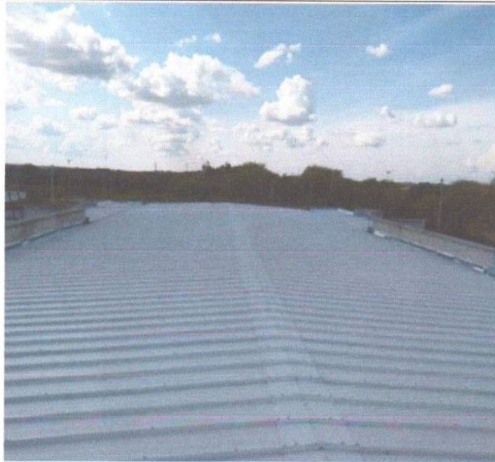
SERVIÇO DE COBERTURA: TELHA SANDUICHE, CUMEEIRA E RUFO METÁLICO.
