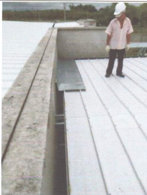
SERVIÇO DE EXECUÇÃO DE RUFO EM CHAPA DE AÇO GALVANIZADO.
