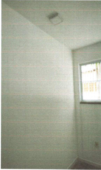
PINTURA DE PAREDE
