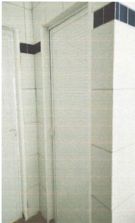
INSTALAÇÃO DE PORTAS
