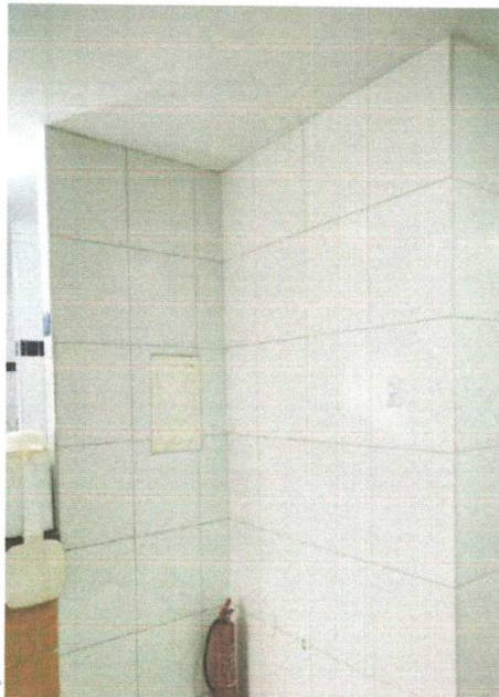
COLOCAÇÃO DE CERÂMICA
