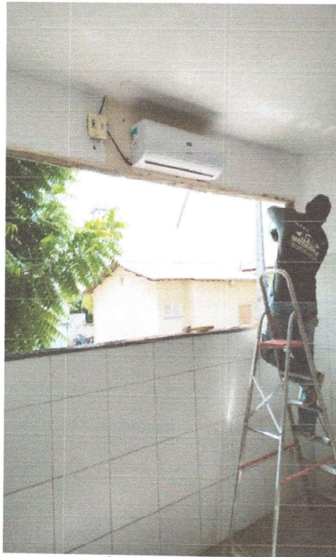
INSTALAÇÃO DE JANELA DE ALUMÍNIO
