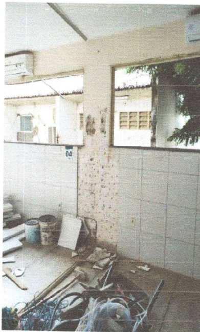
RETIRADAS DE JANELAS
