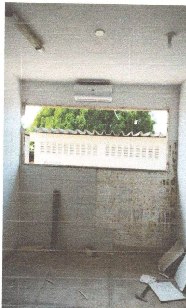
REVESTIMENTO DE CERÂMICA
