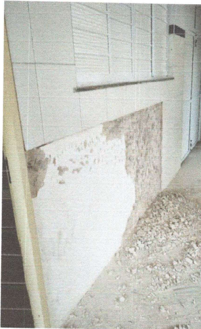
DEMOLIÇÃO DO REVESTIMENTO CERÂMICO
