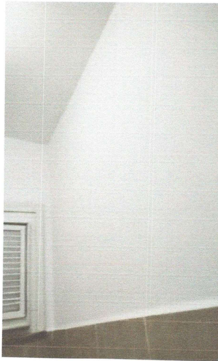
PINTURA DE PAREDES
