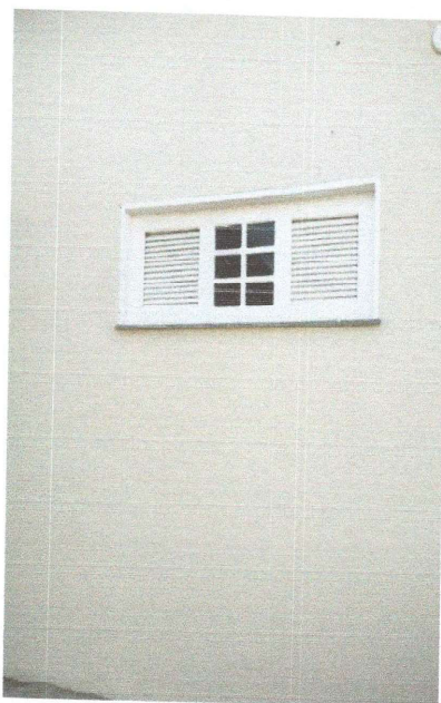
PINTURA EM ESQUADRIAS DE MADEIRA
