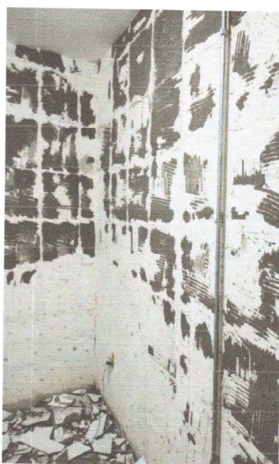
DEMOLIÇÃO DO REVESTIMENTO CERÂMICO
