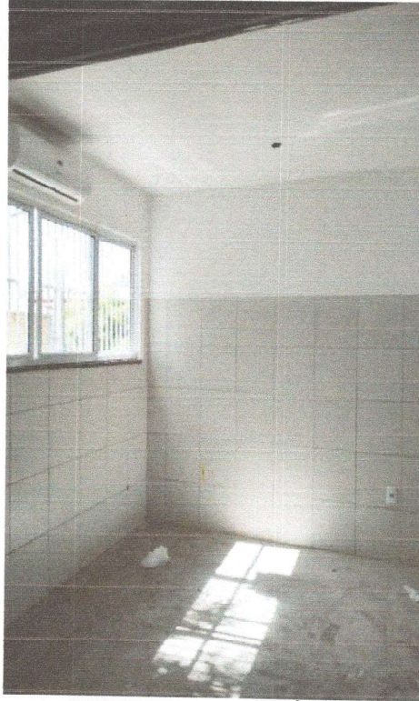
REVESTIMENTO DE CERÂMICA
