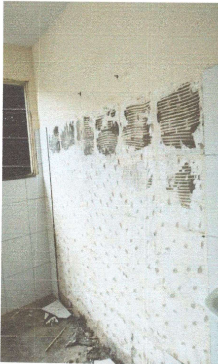
DEMOLIÇÃO DO REVESTIMENTO CERÂMICO
