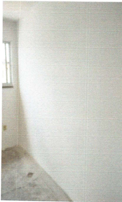
PINTURA DE PAREDES
