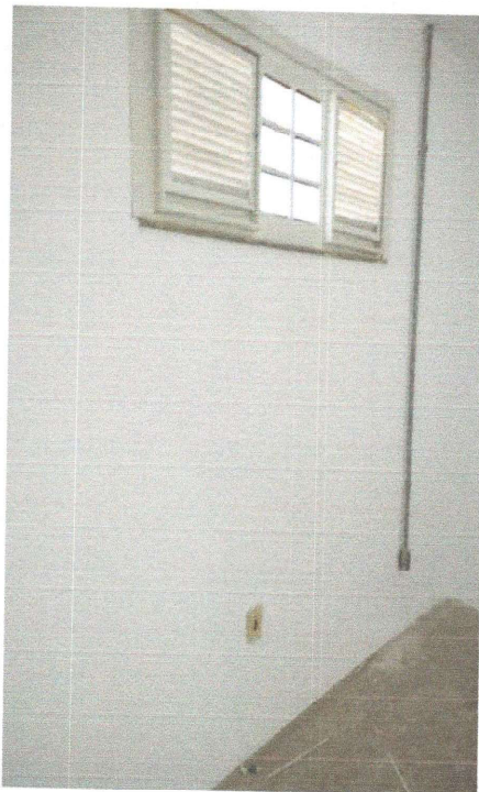
PINTURA DE PAREDES
