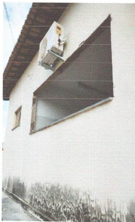
RETIRADAS DE JANELAS
