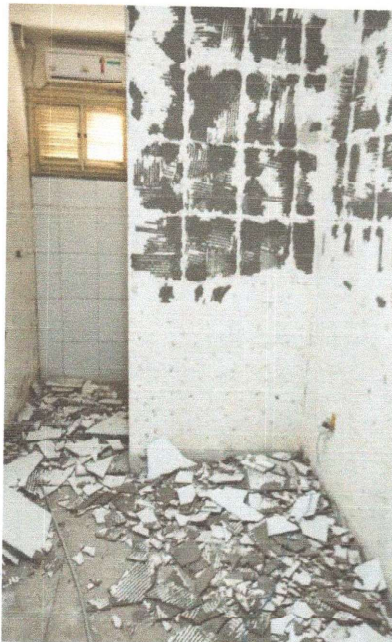
DEMOLIÇÃO DO REVESTIMENTO CERÂMICO
