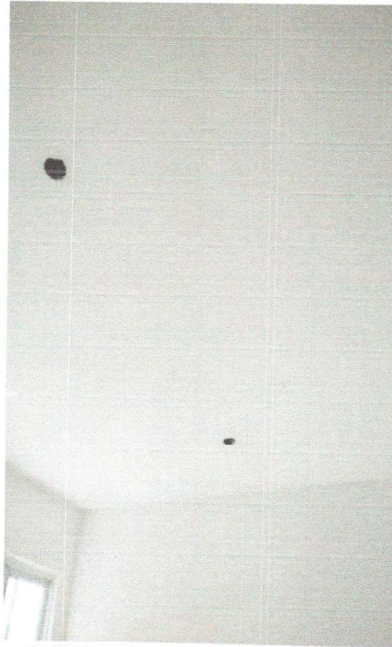
PINTURA COM TINTA LATEX NO TETO
