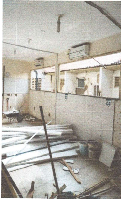
RETIRADAS DE JANELAS
