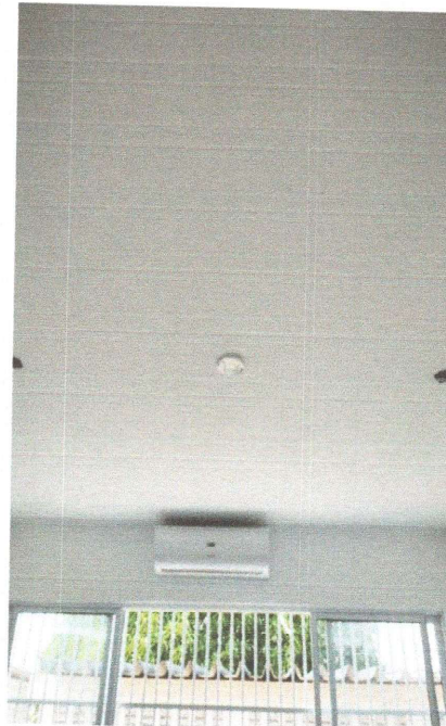
PINTURA COM TINTA LATEX NO TETO
