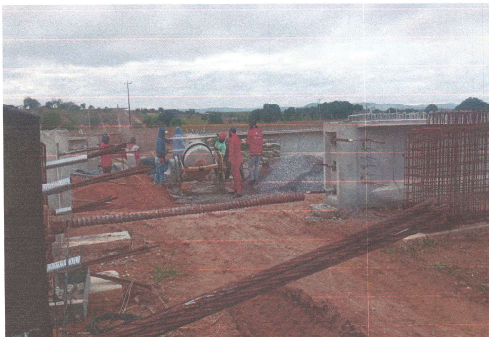
CONCRETAGEM DAS VIGAS
