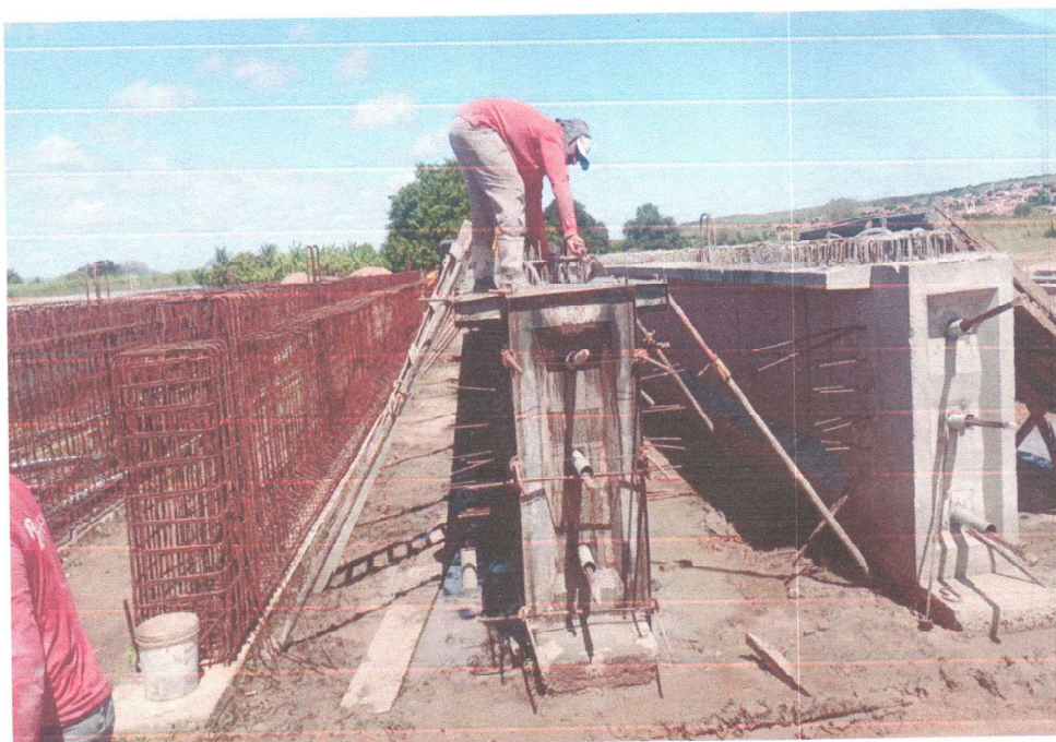
CONCRETAGEM DAS VIGAS
