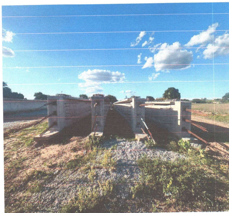
VIGAS CONCRETADAS
