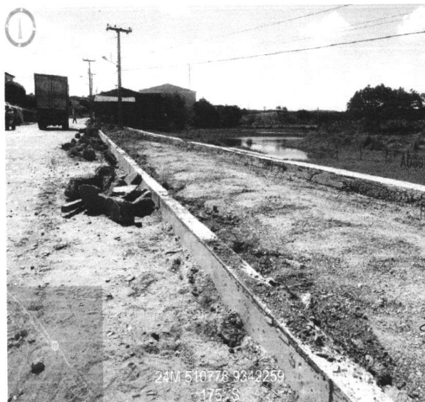
ATERRO C/ COMPACTAÇÃO MECÂNICA (25/01/2023 A 31/01/2023)
