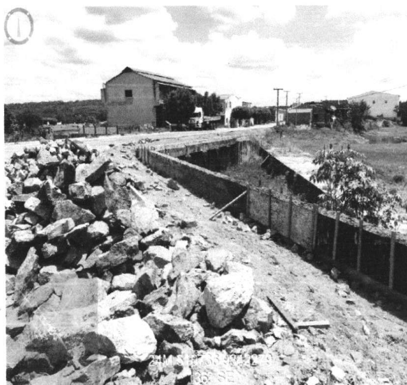
EXECUÇÃO DE ALVENARIA DE PEDRA ARGAMASSADA (13/01/2023 A 20/01/2023)
