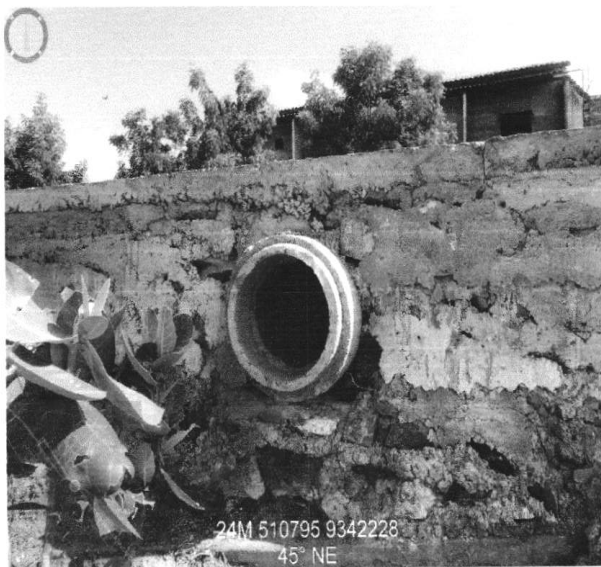
EXECUÇÃO BOCA DE LOBO E ASSESTAMENTO DE TUBO (19/01/2023 A 20/01/2023)
