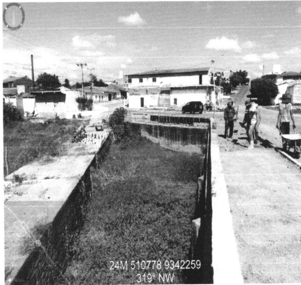
ATERRO C/ COMPACTAÇÃO MECÂNICA (25/01/2023 A 31/01/2023)
