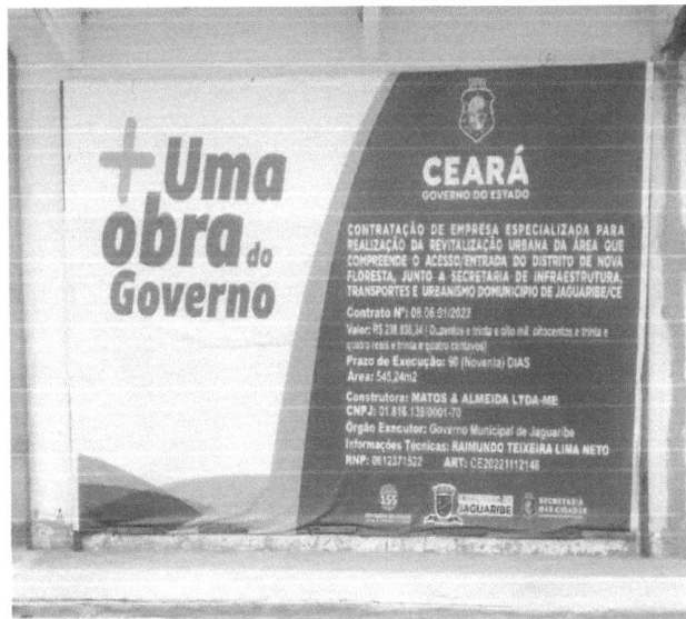
INSTALAÇÃO DE PLACA DE OBRA (12/01/2023)
