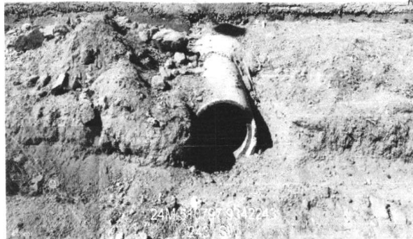
EXECUÇÃO BOCA DE LOBO E ASSESTAMENTO DE TUBO (19/01/2023 A 20/01/2023)
