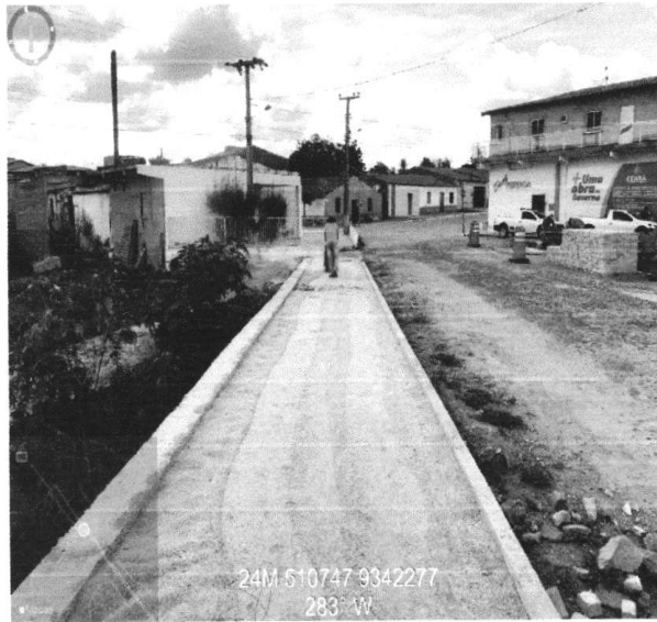
ATERRO C/ COMPACTAÇÃO MECÂNICA (25/01/2023 A 31/01/2023)
