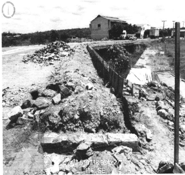
EXECUÇÃO DE ALVENARIA DE PEDRA ARGAMASSADA (13/01/2023 A 20/01/2023)
