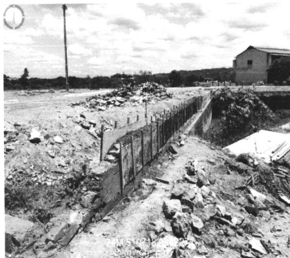
EXECUÇÃO DE ALVENARIA DE PEDRA ARGAMASSADA (13/01/2023 A 20/01/2023)
