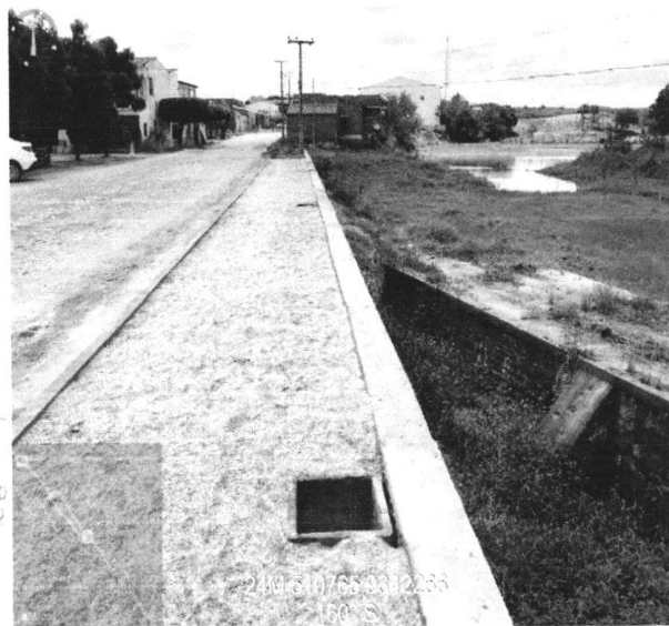
ATERRO C/ COMPACTAÇÃO MECÂNICA (25/01/2023 A 31/01/2023)
