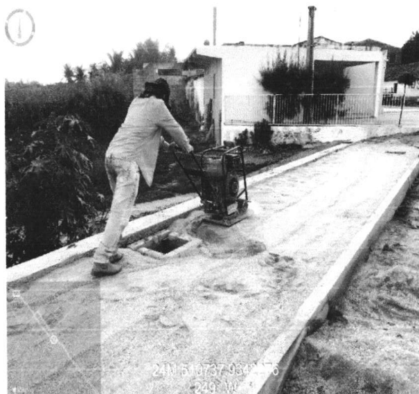
ATERRO C/ COMPACTAÇÃO MECÂNICA (25/01/2023 A 31/01/2023)
