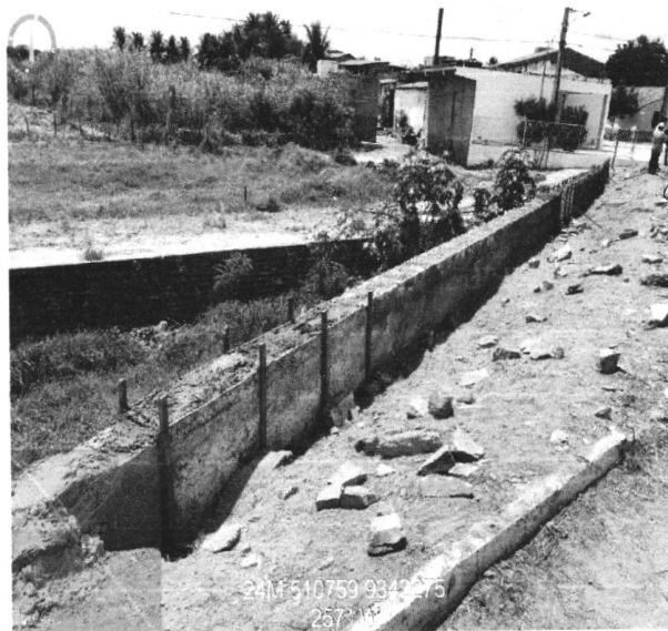
EXECUÇÃO DE ALVENARIA DE PEDRA ARGAMASSADA (13/01/2023 A 20/01/2023)
