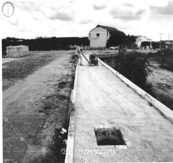
ATERRO C/ COMPACTAÇÃO MECÂNICA (25/01/2023 A 31/01/2023)
