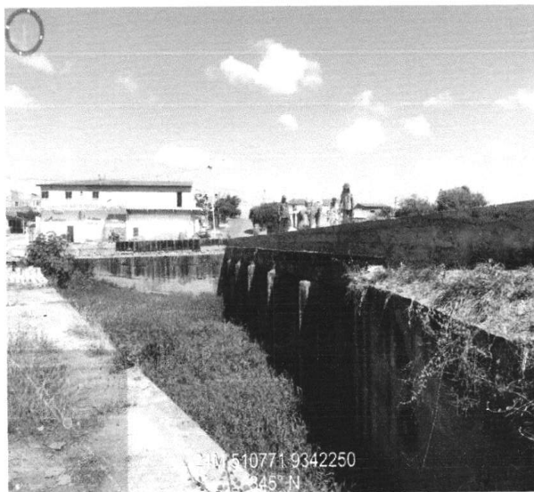
EXECUÇÃO DE ALVENARIA DE PEDRA ARGAMASSADA (13/01/2023 A 20/01/2023)
