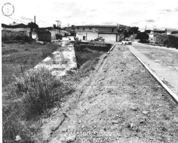
ESCAVAÇÃO MANUAL EM CAMPO ABERTO (11/01/2023 A 12/01/2023)
