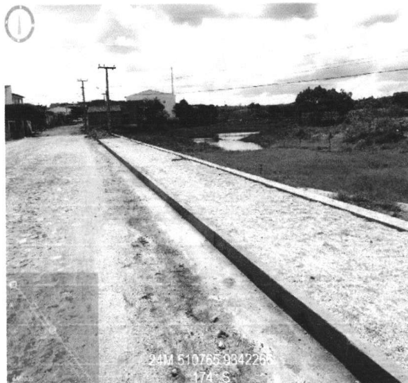
EXECUÇÃO DE SARJETA (23/01/2023 A 24/01/2023)
