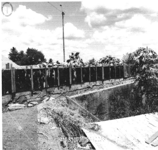
EXECUÇÃO DE ALVENARIA DE PEDRA ARGAMASSADA (13/01/2023 A 20/01/2023)
