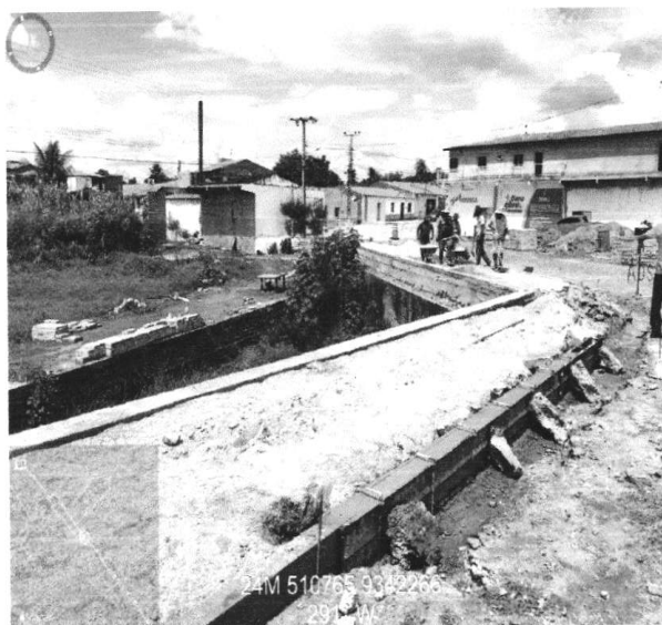
MEIO FIO MOLDADO NO LOCAL (17/01/2023 A 20/01/2023)
