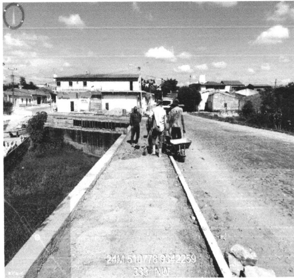
ATERRO C/ COMPACTAÇÃO MECÂNICA (25/01/2023 A 31/01/2023)
