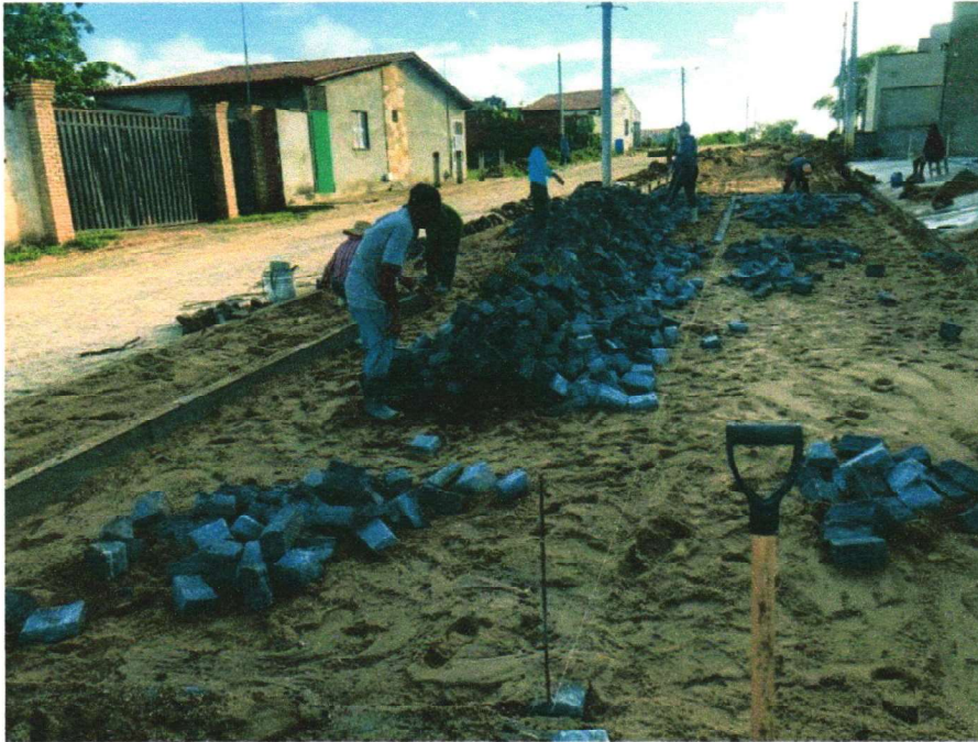
EXECUÇÃO DA PAVIMENTAÇÃO EM PARALELEPÍPEDO
