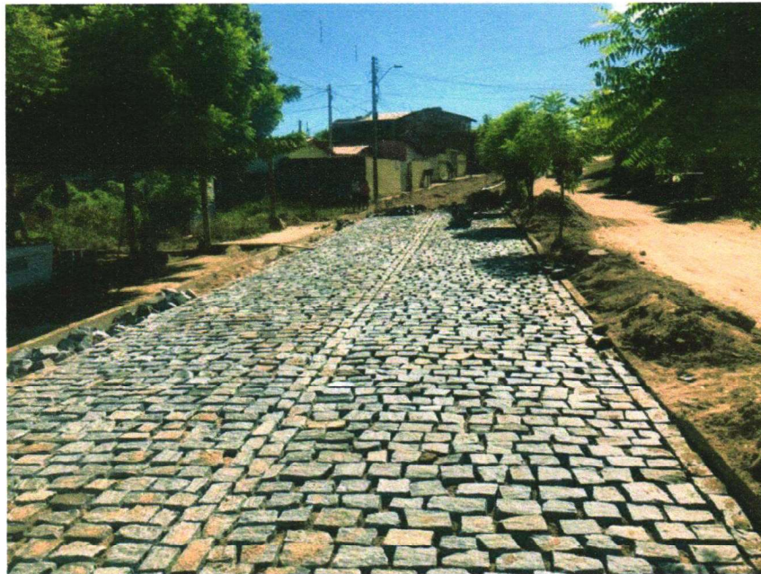
EXECUÇÃO DA PAVIMENTAÇÃO EM PARALELEPÍPEDO
