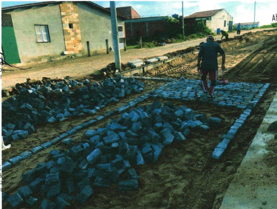
EXECUÇÃO DA PAVIMENTAÇÃO EM PARALELEPÍPEDO
