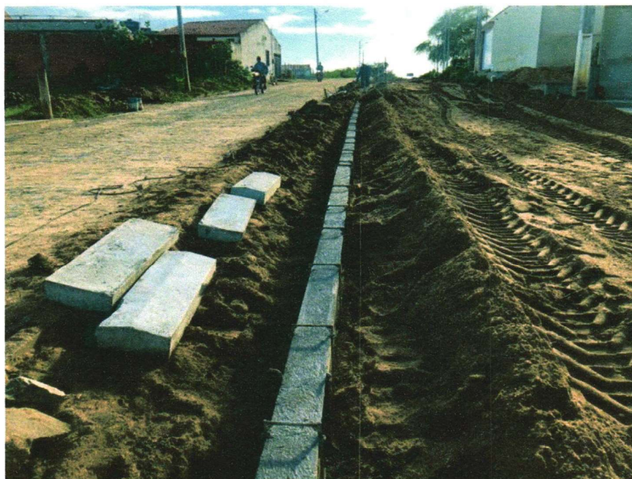
EXECUÇÃO DO MEIO FIO MOLDADO NO LOCAL
