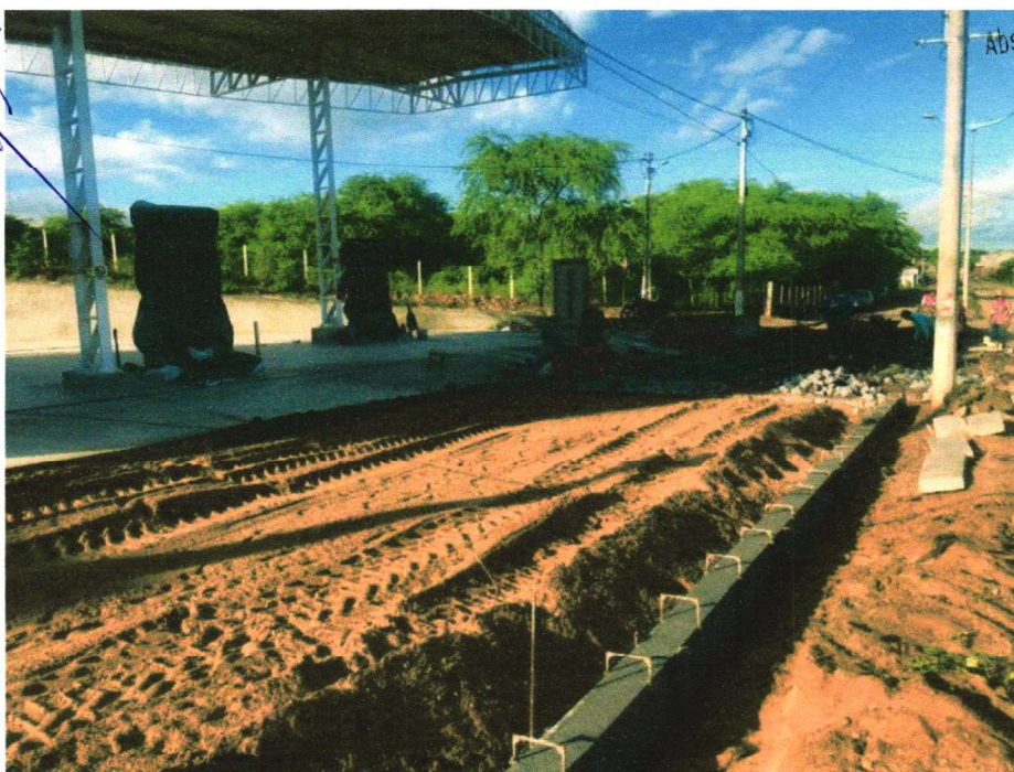
EXECUÇÃO DO MEIO FIO MOLDADO NO LOCAL
