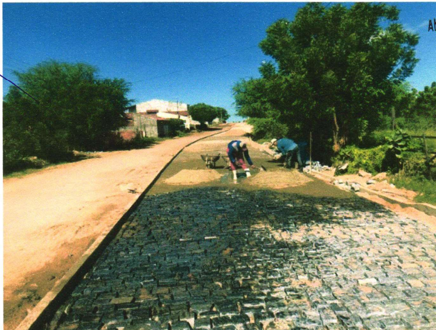
EXECUÇÃO DO REJUNTAMENTO
