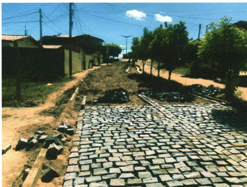
EXECUÇÃO DA PAVIMENTAÇÃO EM PARALELEPÍPEDO
