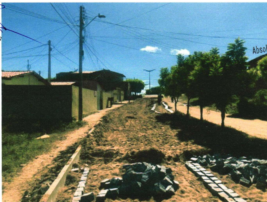
EXECUÇÃO DA PAVIMENTAÇÃO EM PARALELEPÍPEDO
