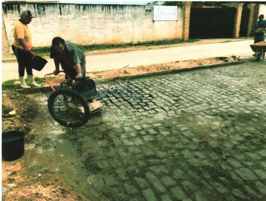
COMPACTAÇÃO DO PAVIMENTO
