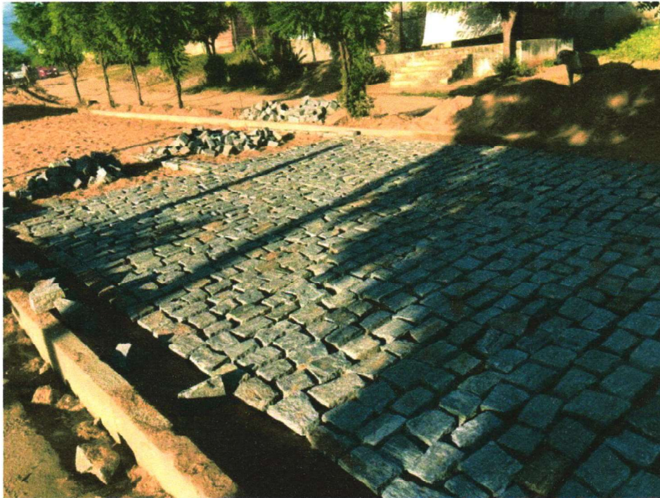
EXECUÇÃO DA PAVIMENTAÇÃO EM PARALELEPÍPEDO
