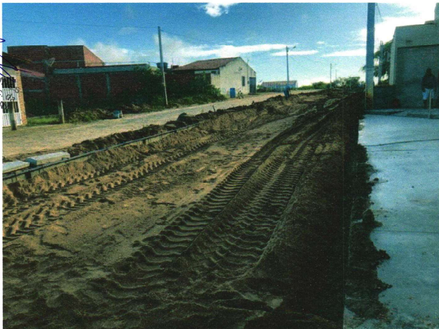
EXECUÇÃO DA PAVIMENTAÇÃO EM PARALELEPÍPEDO
