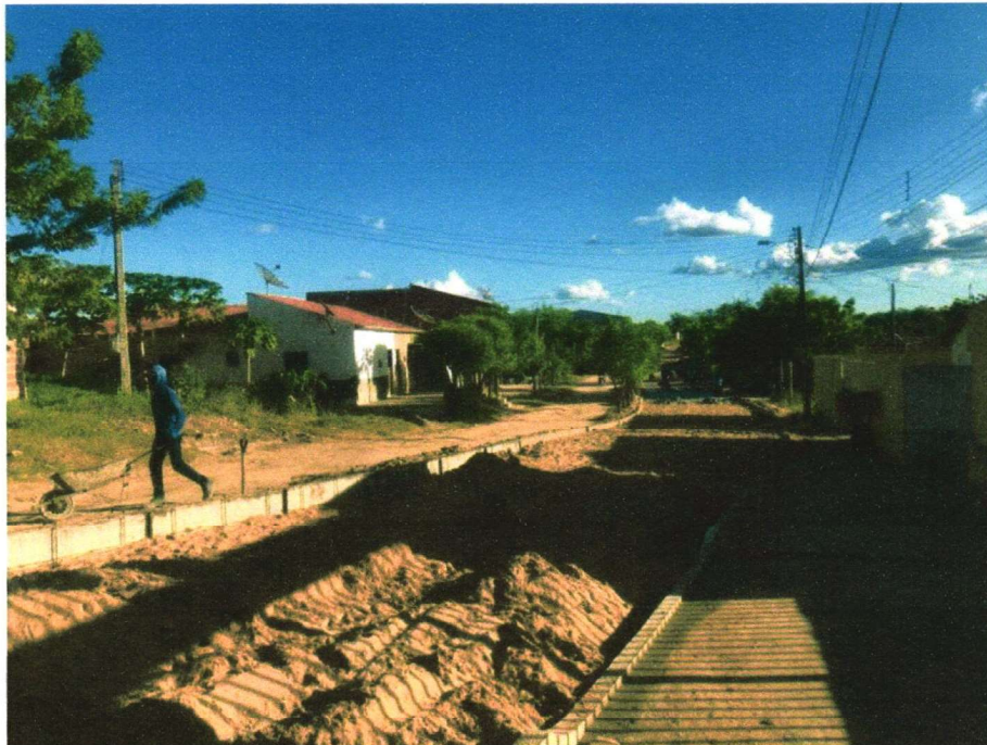
EXECUÇÃO DO MEIO FIO MOLDADO NO LOCAL
