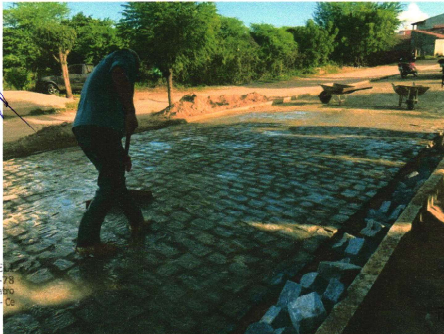
EXECUÇÃO DO REJUNTAMENTO
