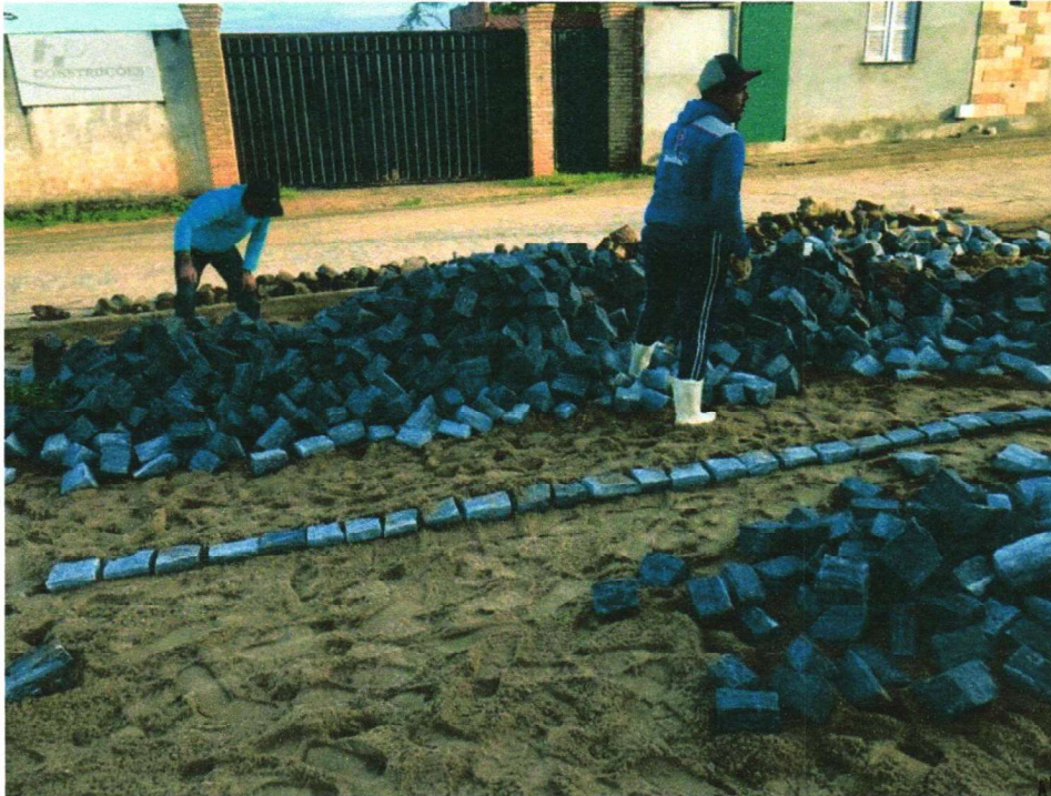
EXECUÇÃO DA PAVIMENTAÇÃO EM PARALELEPÍPEDO
