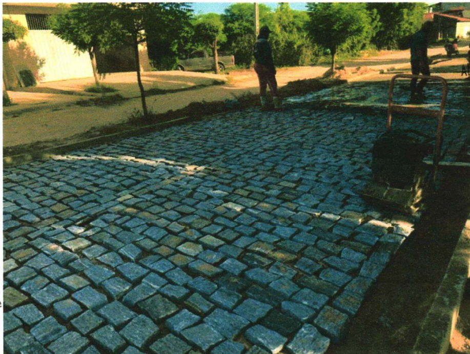
EXECUÇÃO DA PAVIMENTAÇÃO EM PARALELEPÍPEDO
