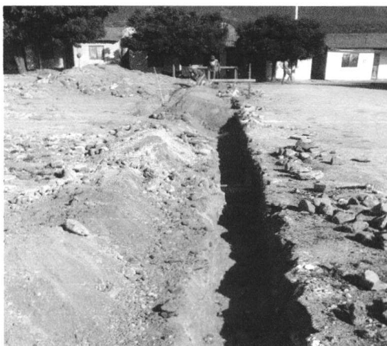
ESCAVAÇÃO DE SOLO – 04/01/2023 A 06/01/2023
