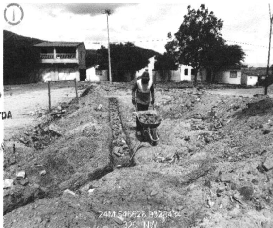
MOTANGEM DE FORMAS PLASTIFICADA E EXECUÇÃO DE ALVENARIA DE PEDRA ARGAMASSADA – 09/01/2023 A
