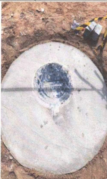
ASSENTAMENTO DE POÇO DE VISITA
