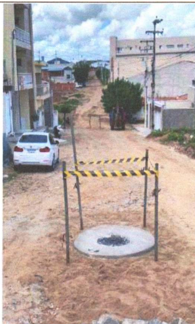
ASSENTAMENTO E SINALIZAÇÃO DE POÇO DE VISITA
