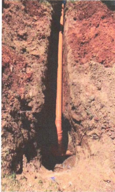
ASSENTAMENTO DE TUBULAÇÃO DE ESGOTO
