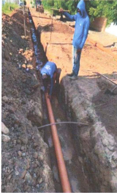
ASSENTAMENTO DE TUBULAÇÃO
