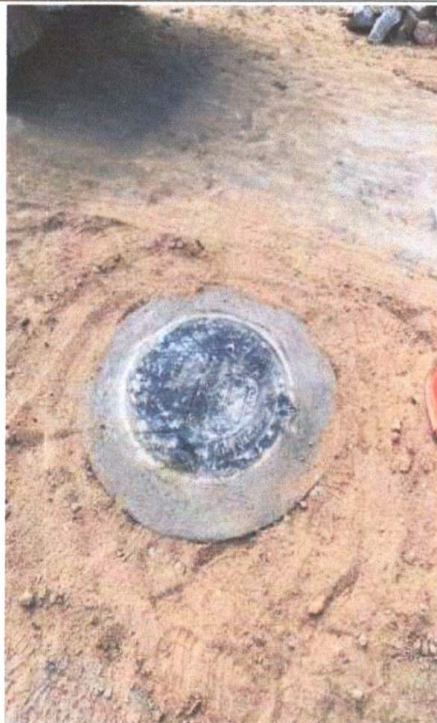
ASSENTAMENTO DE POÇO DE VISITA
