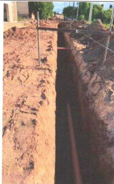
ESCAVAÇÃO DE VALAS PARA ESGOTAMENTO SANITÁRIO
