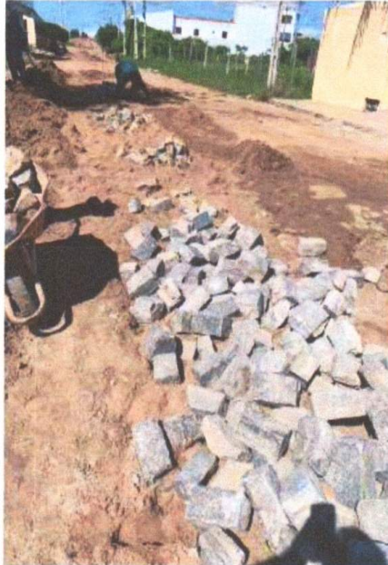
RECOMPOSIÇÃO DE PAVIMENTAÇÃO
