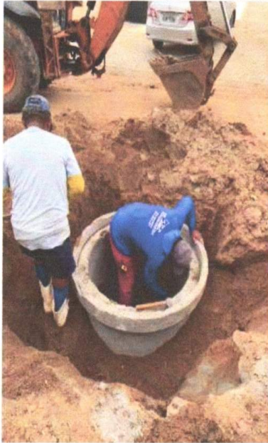
EXECUÇÃO DE POÇO DE VISITA
