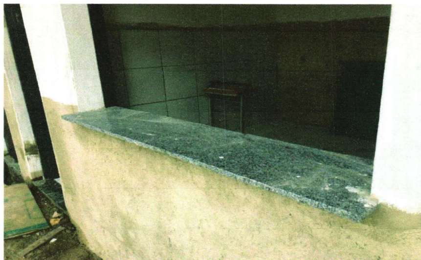
FOTO – 15 – (QUIOSQUE) EXECUÇÃO DA BANCADA DE GRANITO (OUTRAS CORES) ESP. = 2cm– 15/03/2023 A 24/03/2023
