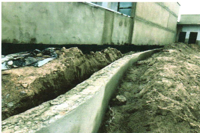
FOTO – 04 – (CANTEIRO) EXECUÇÃO DE REBOCOS DAS JARDINEIRAS – 01/03/2023 A 03/03/2023
