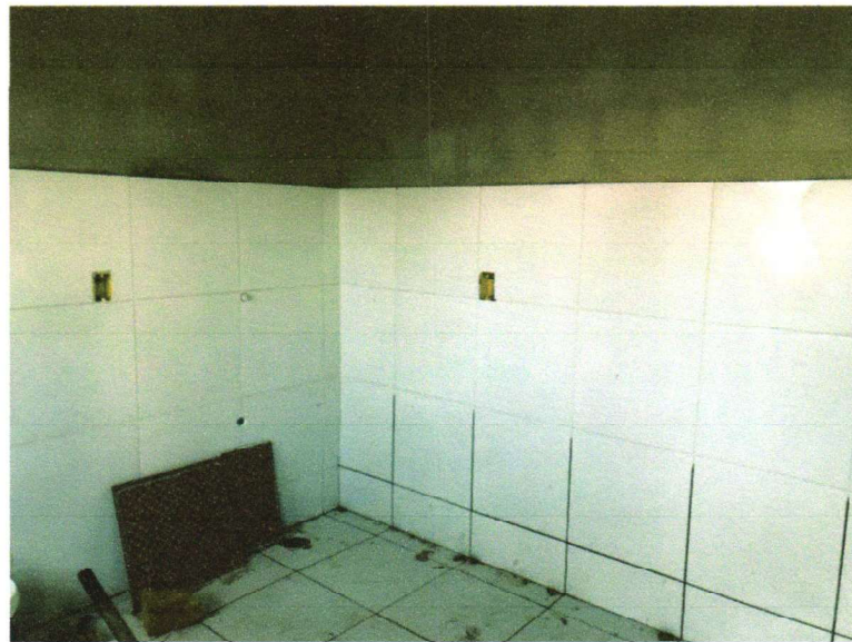
FOTO – 11 – (QUIOSQUE 02) EXECUÇÃO DE REJUNTE NO PISO E PAREDES INTERNOS NA ALTURA 1,60M, – 09/03/2023 A 20/03/2023
