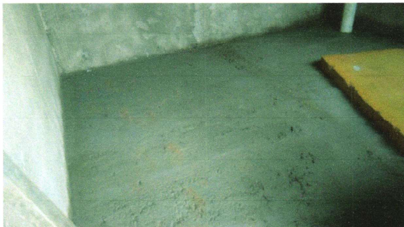
FOTO – 08 – (QUIOSQUE 02) EXECUÇÃO DE LASTRO DE CONCRETO ESP.= 5CM – 06/03/2023 A 08/03/2023
