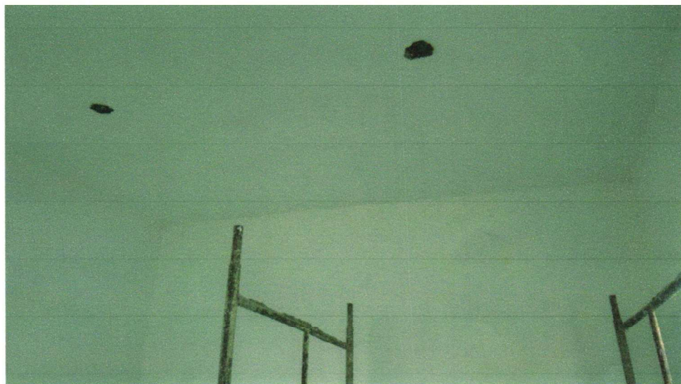
FOTO – 24 – (QUIOSQUE 01) EXECUÇÃO DE CHAPIM PRÉ-MOLDADO DE CONCRETO, - 31/03/2023
