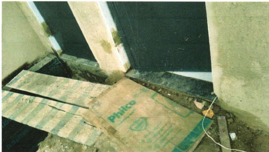
FOTO – 16 – (QUIOSQUE) EXECUÇÃO DE PORTA DE FERRO EM CHAPA, COM SOLEIRA DE GRANITO L= 15cm – 15/03/2023 A 24/03/2023
