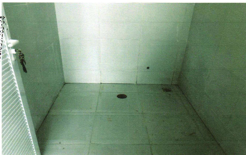
FOTO – 10 – (BANHEIRO) EXECUÇÃO DE CERAMICA NO PISO E PAREDE INTERNAS NA ALTURA 1,60M, COM REJUNTE – 09/03/2023 A 20/03/2023
