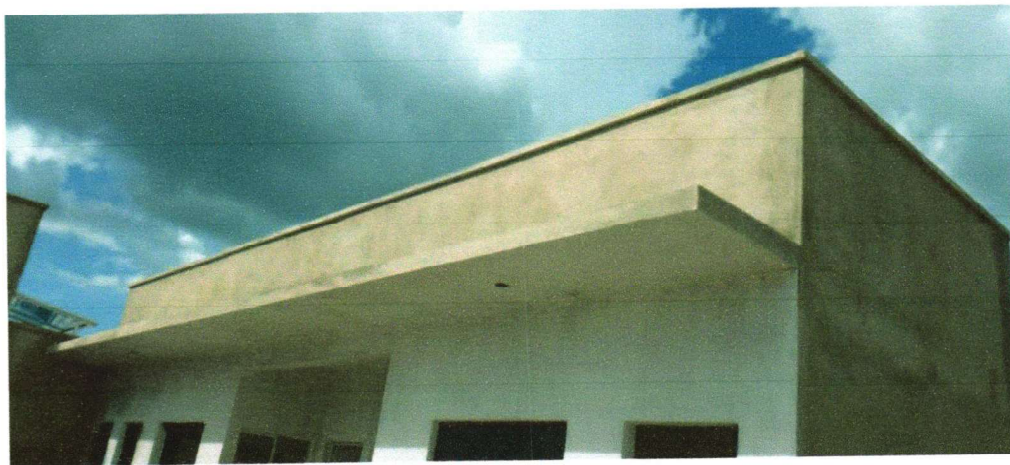
FOTO – 18 – (COBERTURA) EXECUÇÃO DE CHAPIM PRÉ-MOLDADO DE CONCRETO, - 27/03/2023 A 28/03/2023
