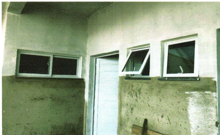
FOTO – 12 – (QUIOSQUE - BANHEIROS) EXECUÇÃO DO PORTA DE ALUMÍNIO E JANELAS COM VIDROS – 13/03/2023 A 17/03/2023
