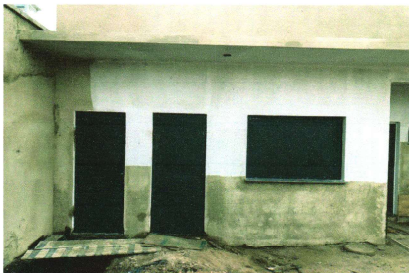
FOTO – 13 – (QUIOSQUE) EXECUÇÃO DO PORTA DE FERRO COMPACTA EM CHAPA E BANCADA DE GRANITO (OUTRAS CORES) ESP. = 2cm– 14/03/2023 A 17/03/2023
