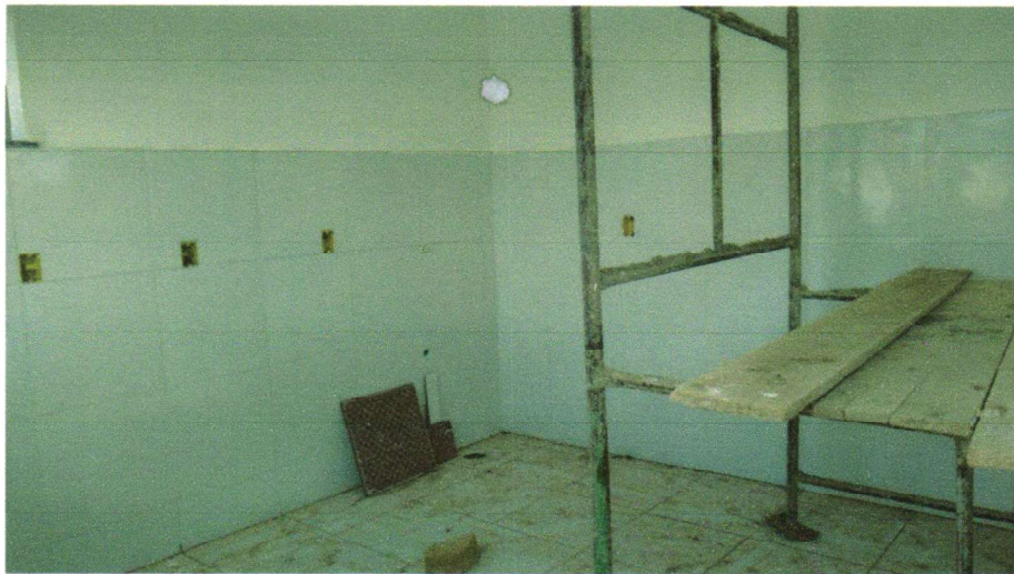
FOTO – 09 – (QUIOSQUE 01) EXECUÇÃO DE CERAMICA NO PISO E PAREDE INTERNAS NA ALTURA 1,60M – 09/03/2023 A 20/03/2023
