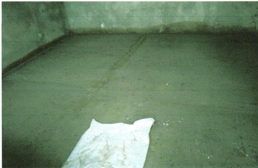
FOTO – 05 – (QUIOSQUE 01) EXECUÇÃO DE LASTRO DE CONCRETO ESP.= 5CM – 06/03/2023 A 08/03/2023
