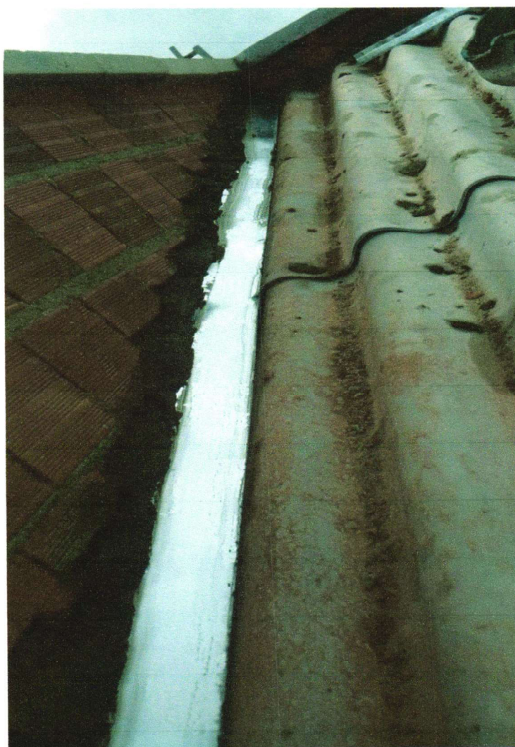
FOTO – 20 – (COBERTURA) EXECUÇÃO DO RUFO, - 28/03/2023 A 29/03/2023
