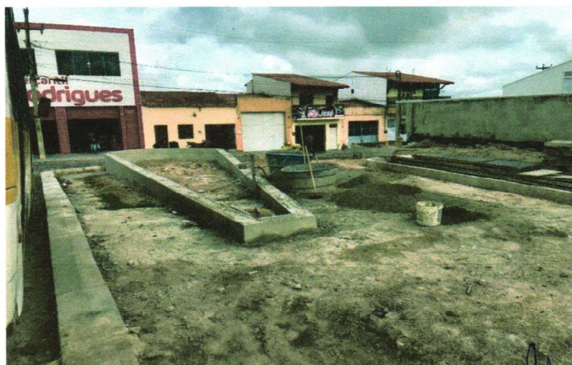
FOTO – 02 - (CANTEIRO) EXECUÇÃO DE REBOCOS DAS JARDINEIRAS– 01/03/2023 A 03/03/2023
