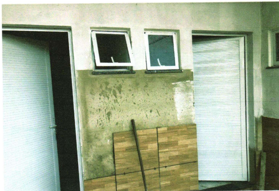
FOTO – 22 – EXECUÇÃO DE CERÂMICA NAS PAREDES EXTERNAS NA ALTURA DE 1M, - 27/03/2023 A 31/03/2023
