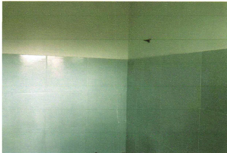
FOTO – 14 – (QUIOSQUE 01) EXECUÇÃO DE EMASSAMENTO DE PAREDES INTERNAS 2 DEMÃOS C/MASSA DE PVA– 15/03/2023 A 24/03/2023
