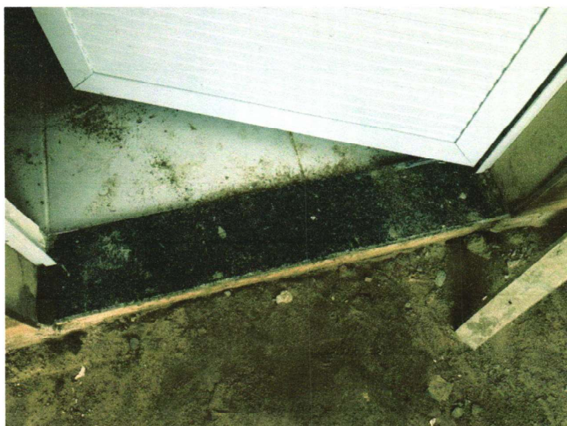
FOTO – 17 – EXECUÇÃO SOLEIRA DE GRANITO L= 15cm – 15/03/2023 A 24/03/2023
