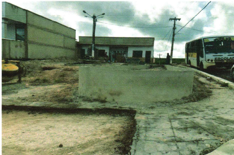
FOTO – 03 – (CANTEIRO) EXECUÇÃO DE REBOCOS DAS JARDINEIRAS – 01/03/2023 A 03/03/2023
