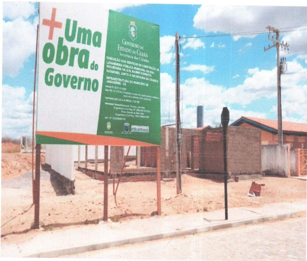
FOTO - 01 - PLACA DA OBRA
