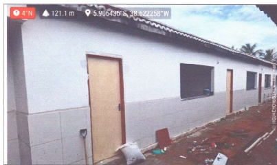
EXECUÇÃO DE REVESTIMENTOS E ESQUADRIAS
