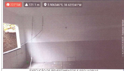
EXECUÇÃO DE REVESTIMENTOS E ESQUADRIAS
