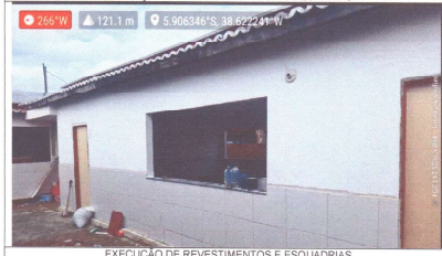
EXECUÇÃO DE REVESTIMENTOS E ESQUADRIAS
