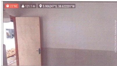
EXECUÇÃO DE REVESTIMENTOS E ESQUADRIAS
