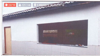
EXECUÇÃO DE REVESTIMENTOS E ESQUADRIAS
