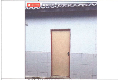
EXECUÇÃO DE REVESTIMENTOS E ESQUADRIAS
