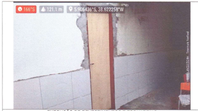
EXECUÇÃO DE REVESTIMENTOS E ESQUADRIAS
