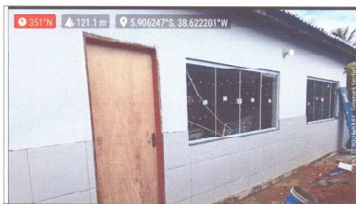
EXECUÇÃO DE REVESTIMENTOS E ESQUADRIAS
