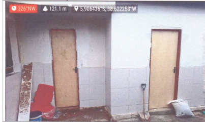
EXECUÇÃO DE REVESTIMENTOS E ESQUADRIAS
