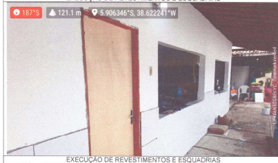
EXECUÇÃO DE REVESTIMENTOS E ESQUADRIAS
