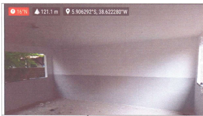
EXECUÇÃO DE REVESTIMENTOS
