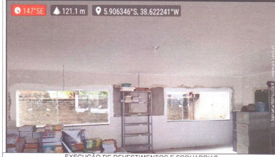
EXECUÇÃO DE REVESTIMENTOS E ESQUADRIAS
